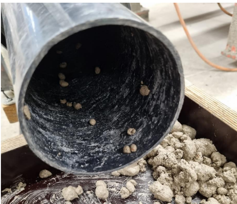
Kuva 20. Viemäriputken tasainen sisäpinta
