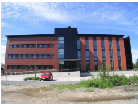
KUVA 8. Julkisivukuva Mikkelin ammattikorkeakoulun rakennuksesta
