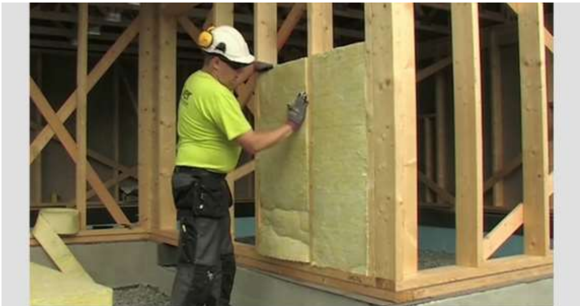
KUVA 4. Villan asennusta runkotolppien väliin (12)
