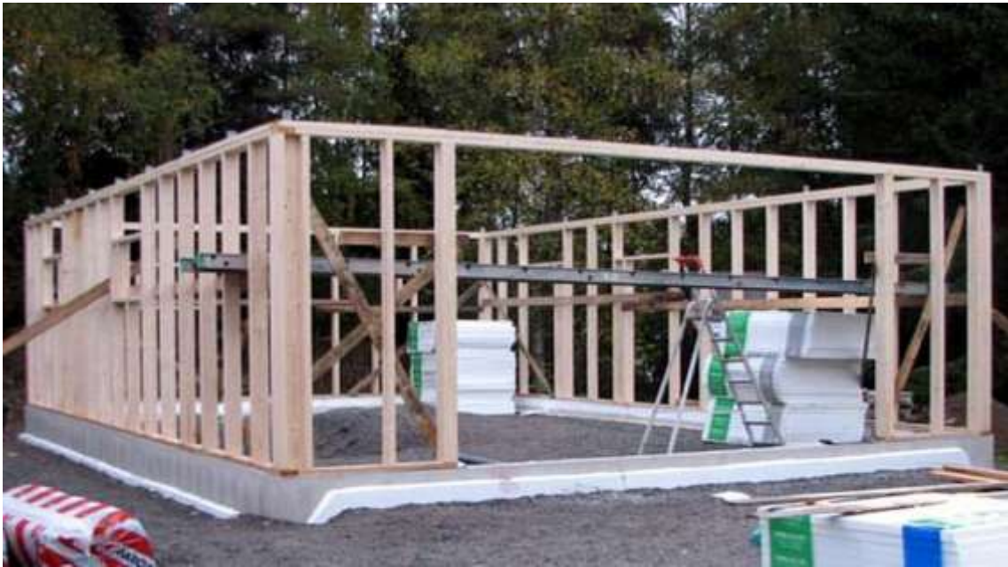
KUVA 3. Rakennuksen runko pystytettynä (9)
