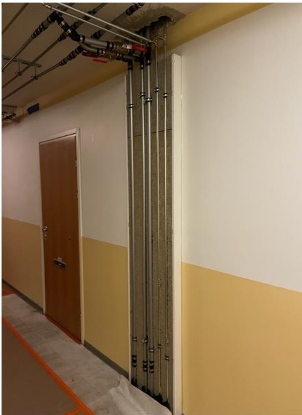
KUVA 3. Uusien putkien nousu porrashuoneessa
