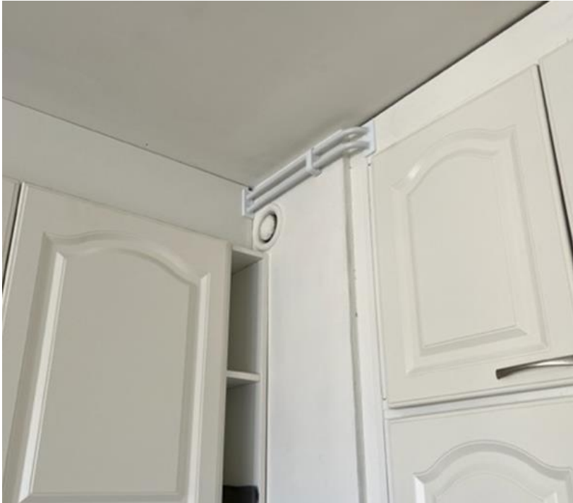
KUVA 8. Keittiöön tulevat vesiputket
