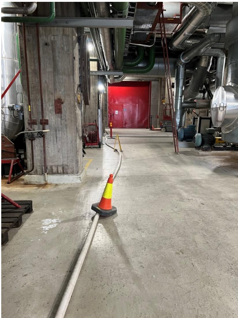
Kuva 7. Paloletku palopostista pehmentyysuodattimille.
