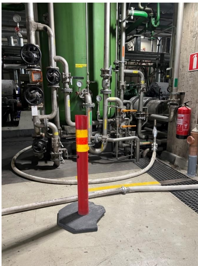
Kuva 6. Talousveden ohjaaminen paloletkulla pehmennyssuodattimille.
