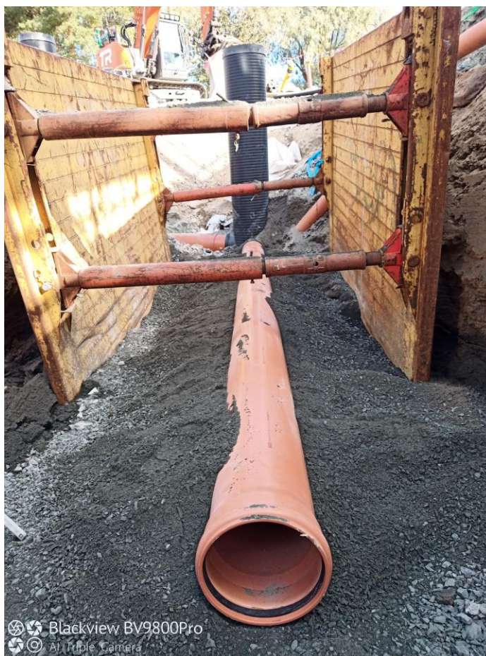
Kuva 15, Jätevesiviemäriin asennusta kaivantotuen kanssa (Anette 2022)
