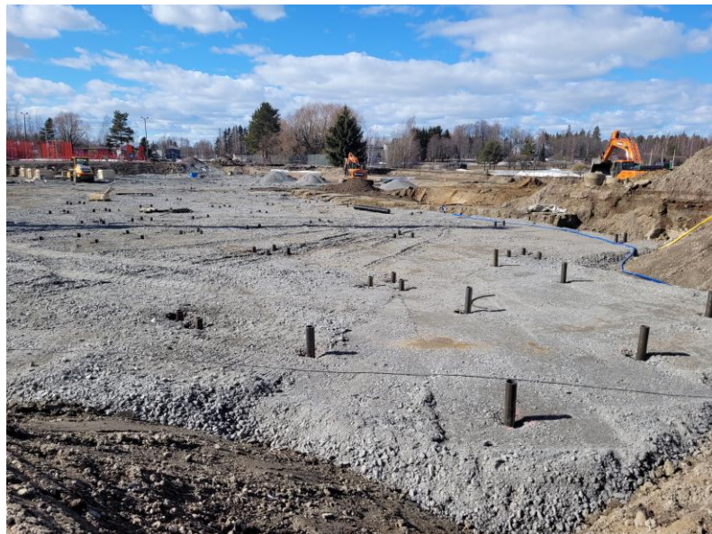
Kuva 14, Rakennuksen perustusten pohjien tekoa (Anette 2022)
