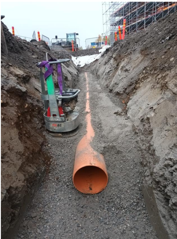
Kuva 17, Putkikaivannon täytöt (Anette 2022)
