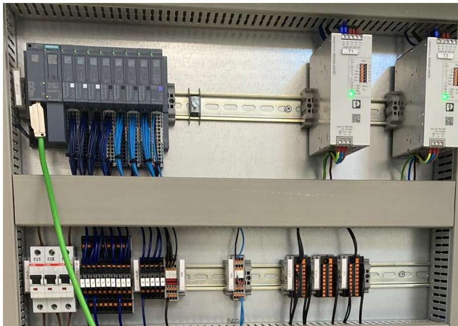
Kuvio 3. Siemens PLC:n etä-IO yksikkö kalustettuna tuotantolaitteen automaatiokeskukseen.
