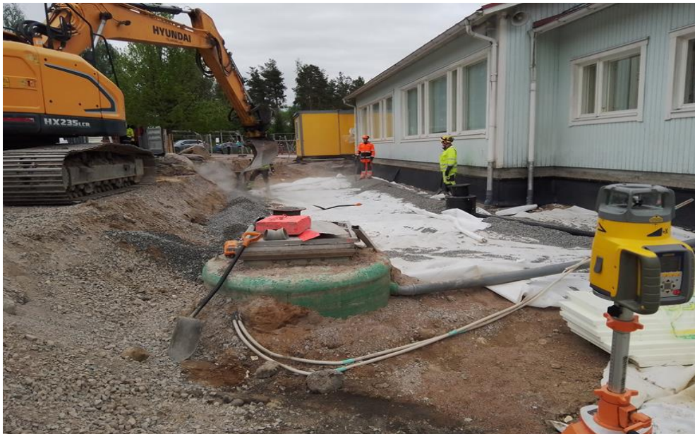
Kuva 18. Työmaalla mittaamista ja jätevesipumppaamon asennus. [15]
