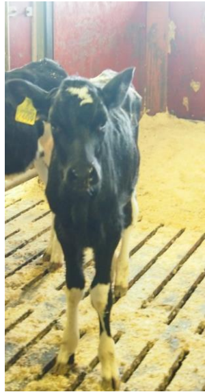
Kuva 20. Ruokinta-alueen betoniritilälattia pysyy kuivana eikä ole liukas.
