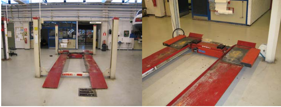
Kuva 7. Nelipilarinostin siirtolevyillä. Siirtolevyt ovat paineilma käyttöiset.
