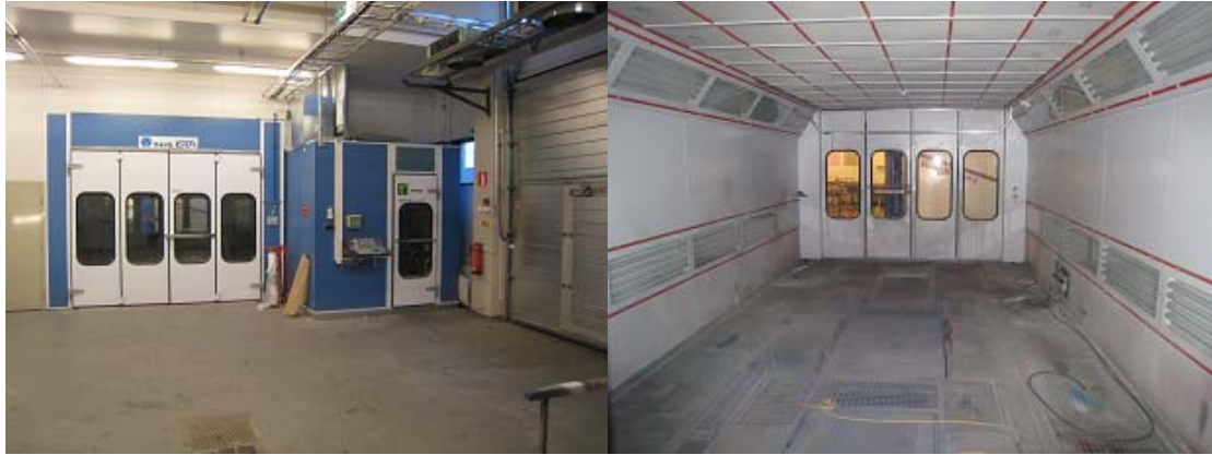
Kuva 3. Maalausammio ja maalivarasto ja oikealla maalausammio sisältä
