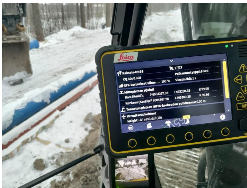
Kuva 17. Työmaa-aidan jalustan päälle on mitattu ja merkattu tarkistuksen aikainen piste, johon kaivinkoneen kauha on siirretty.
