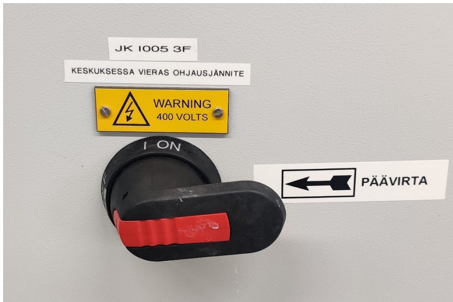
KUVA 4. Sähkökaapin päävirtakytkin.
