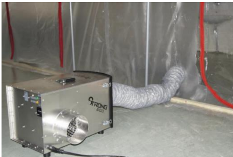
Kuva 6. Osastointi alipaineistajalla. (Strong-Finland Oy, n.d.-a)
