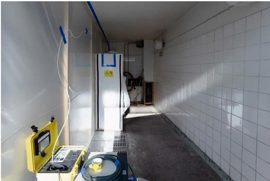
Kuva 5. Asbestinpurku osastointimenetelmällä. (M.R Partners Oy, n.d.)
