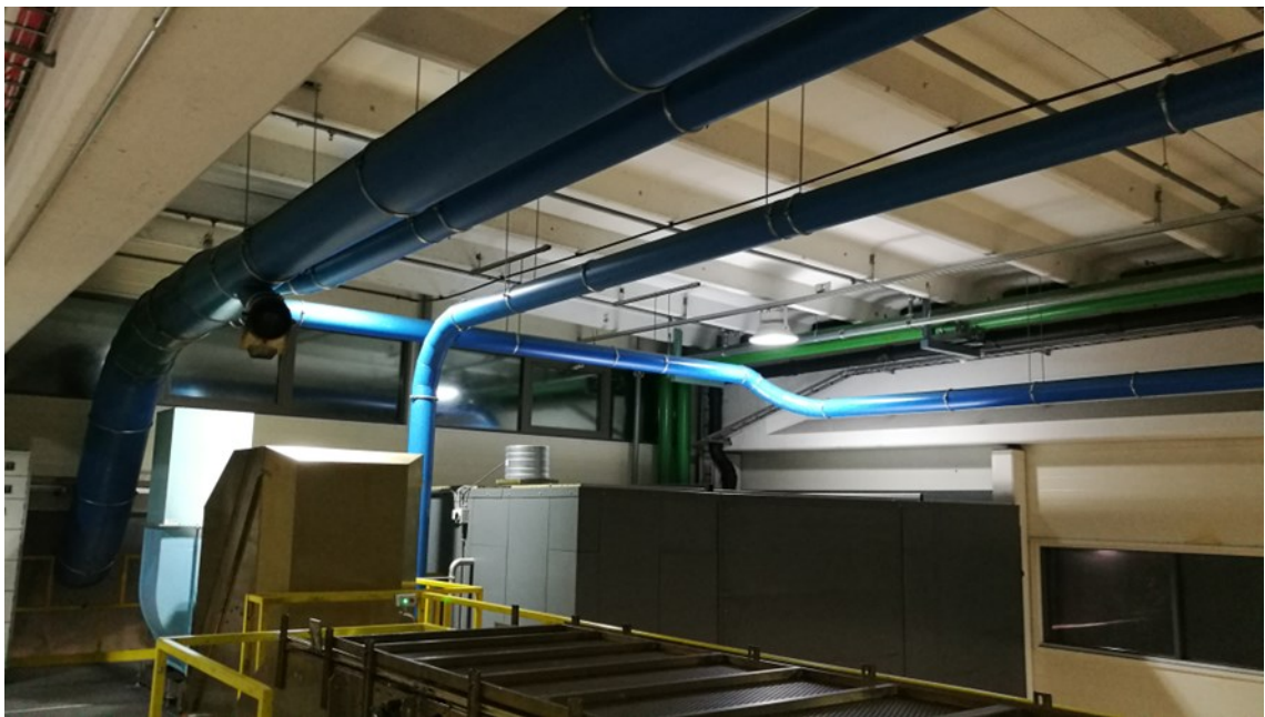
Kuva 6. Kuvassa imuputkiston ensimmäisen haaran rakenne.
