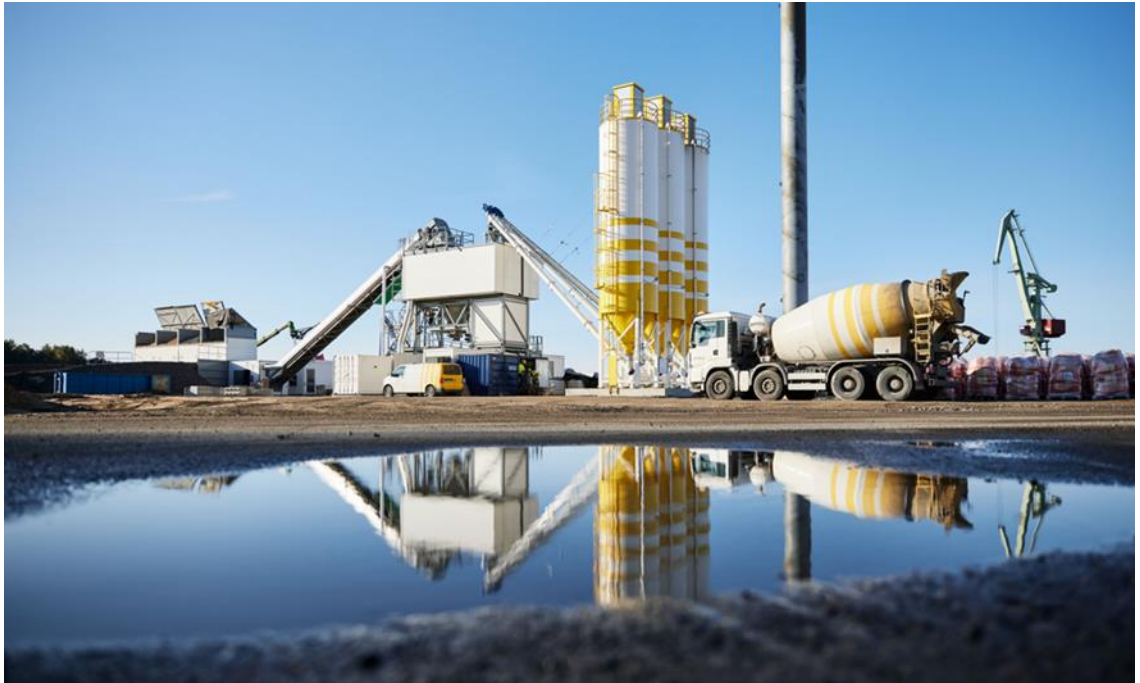
Kuva 4. Mobiilitehdas Porin Mäntyluodossa (Rudus Oy 2022)
