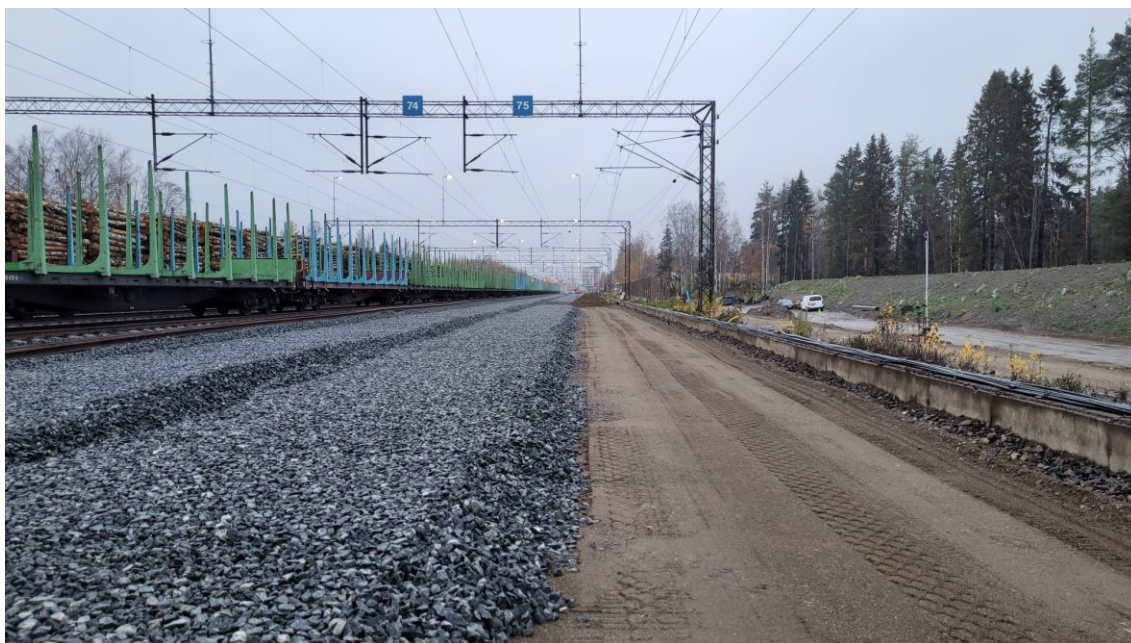
Kuva 1. Uutta radanpohjaa. Tässä kohtaa on vaihdettu pelkästään tukikerros. Alue odottaa viimeisen raiteen pohjasepelöintiä ja päällysrakenteen rakentamista.
