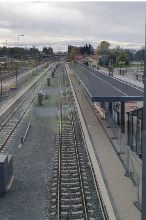
Kuva 2. Kuvassa Joensuun asemalle rakennettua sivulaituria. Kuva otettu uudelta ylikulkusillalta
