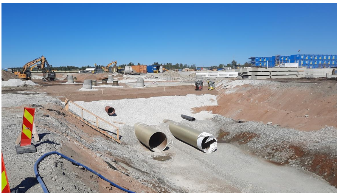
KUVA 1. Luiskaamalla toteutettu putkikaivanto (kuva: Eljas Tyni)
