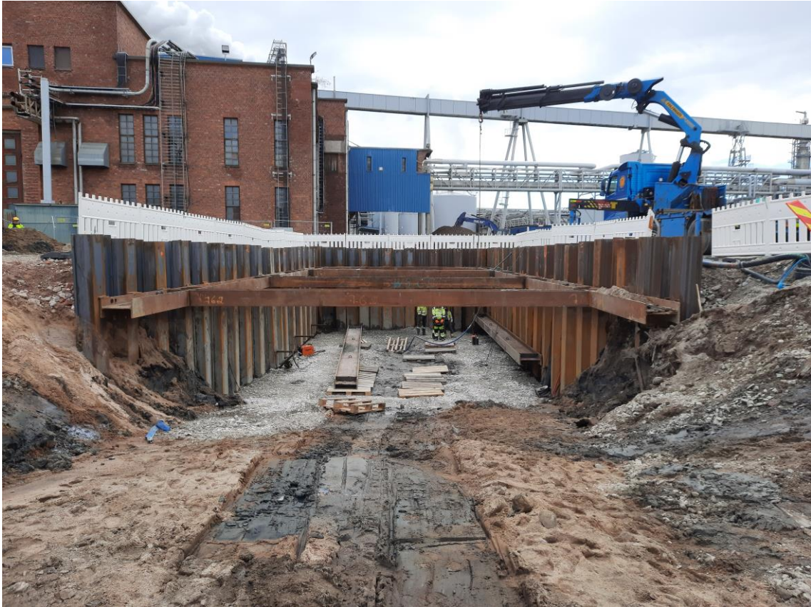
KUVA 2, Teräsponttimenetelmällä tuettu kaivanto (kuva: Eljas Tyni)
