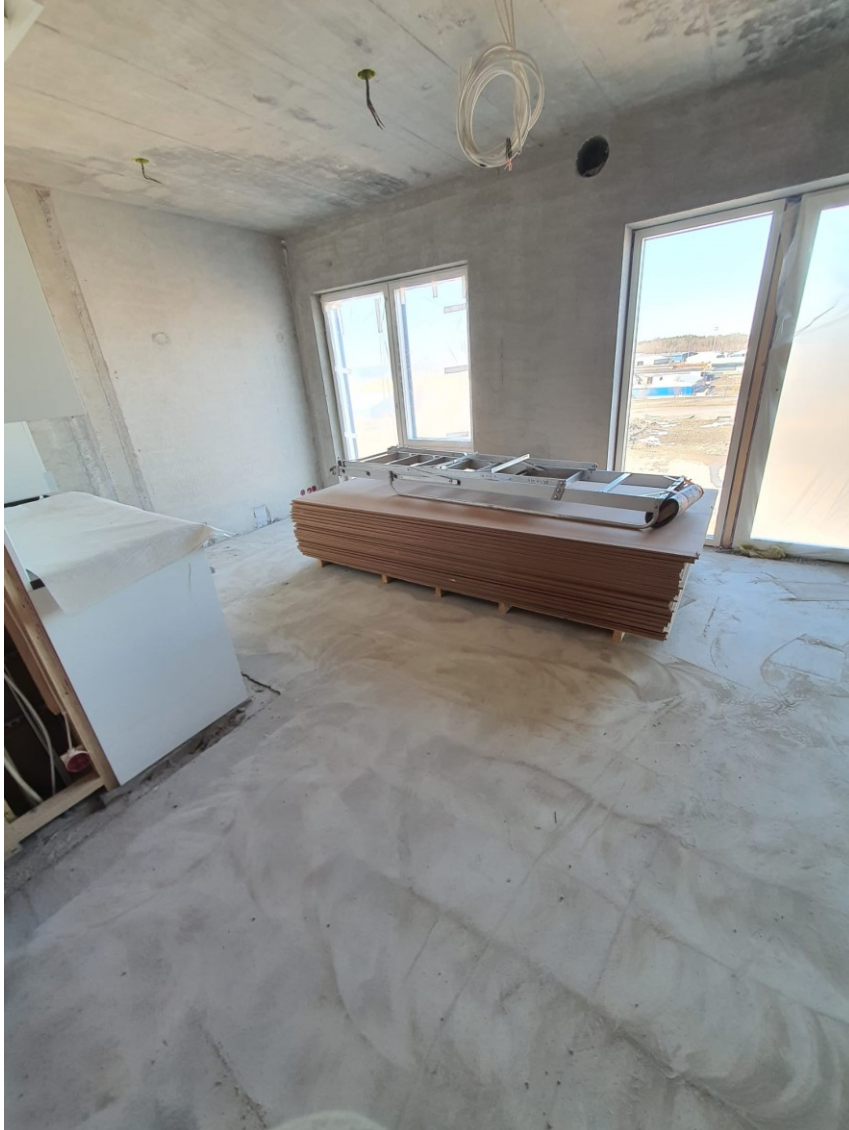
Kuva 7. Kipsilevyt nostettu valmiiksi kerrokseen.
