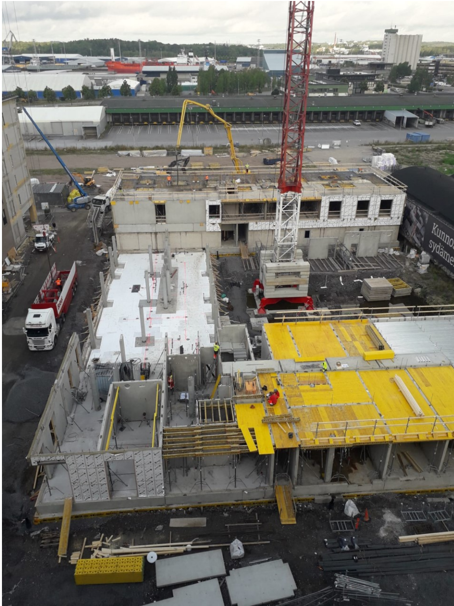
Kuva 6. Yleiskuvaa työmaan logistiikasta.
