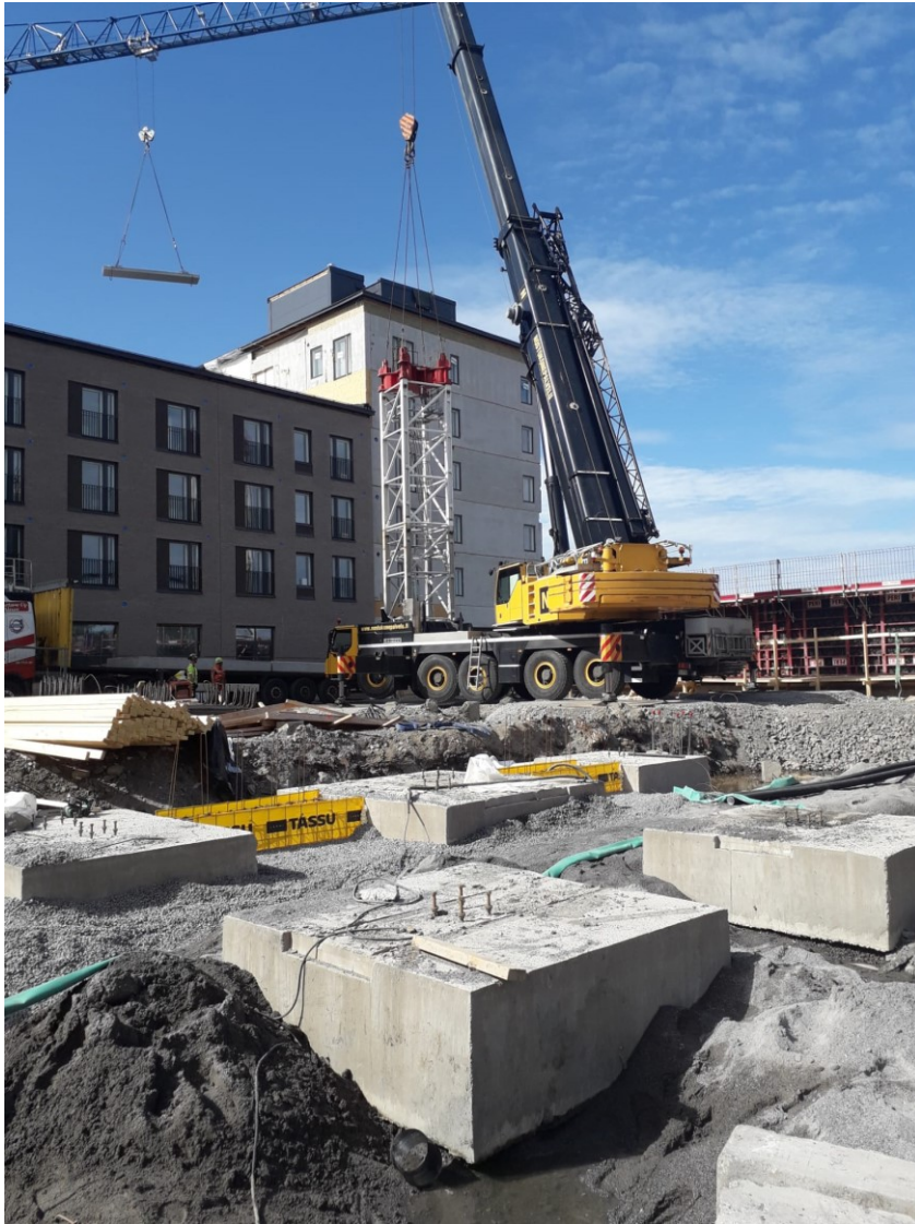
Kuva 2. Torninosturin pystytys työmaalla.
