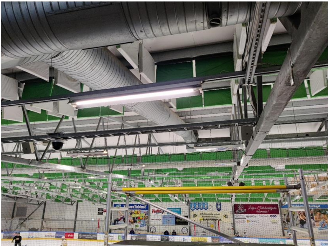
Kuvio 8. Asennus telineiltä tuettuun kiskopalkkiin kattorakenteiden välissä. Kuva: Jimi Rajala, 2022.
