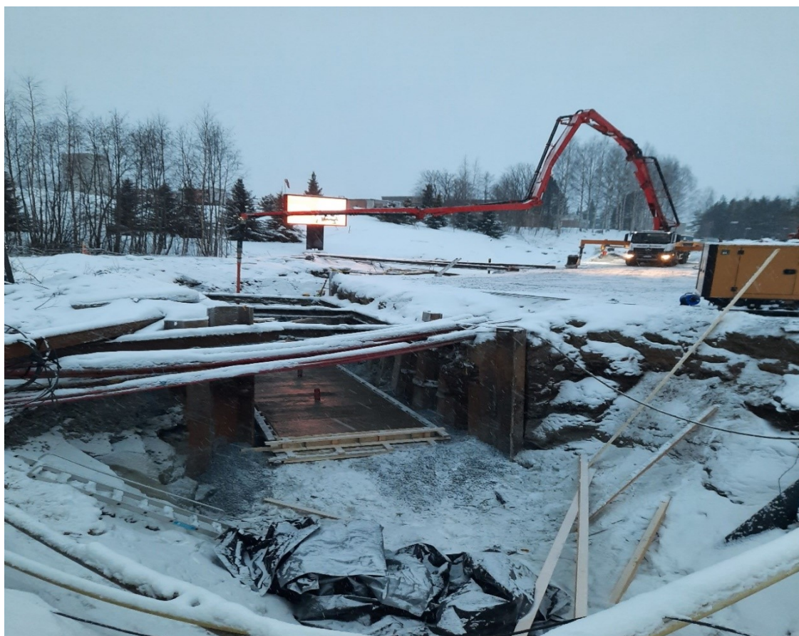
Kuva 16. Pumppuauton sijoittelu työmaalle (Pitkänen 2021)
