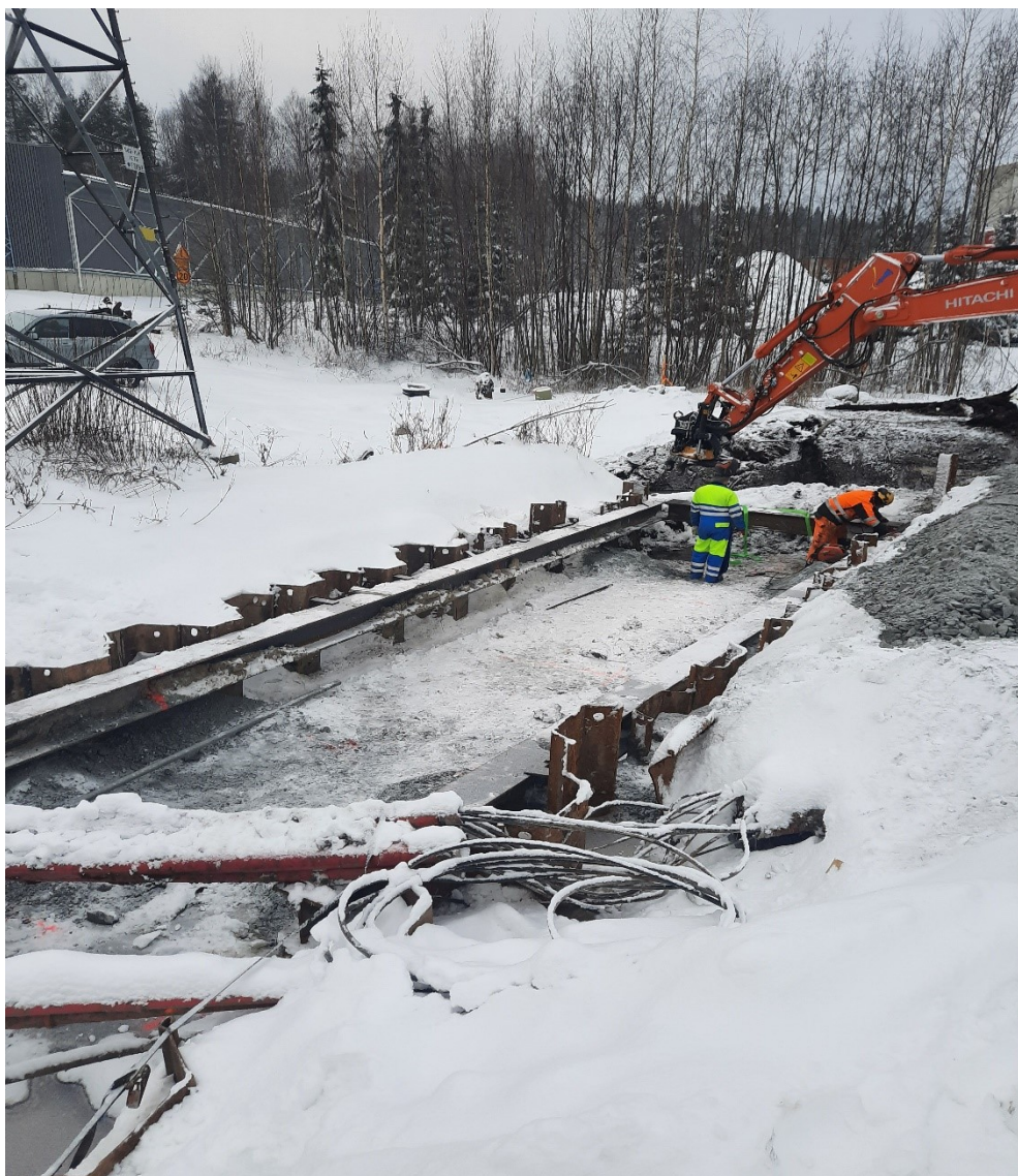
Kuva 12. Teräsponttiseinämien rakentaminen (Pitkänen 2021)
