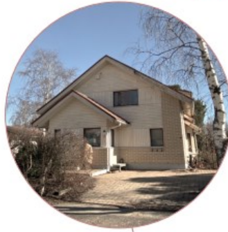
Pohjoinen Sunnuntaipalstojen pientaloalue 1910 →
