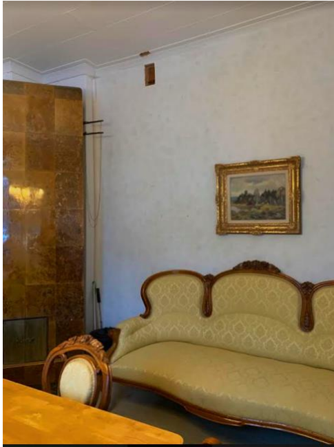
Kuva 7. Katon ja seinäpinnan avaukset salongin interiöörissä.
