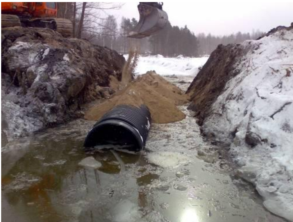
Kuvio 13: Laajalahden ja Lievestuoreenjärven erottavaan penkereeseen rakennettu rumpu
