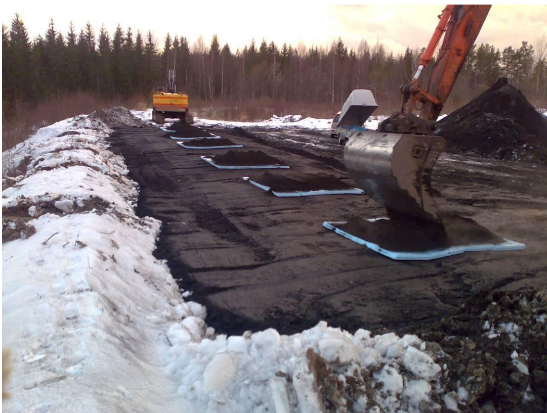
Kuvio 33: Koekenttien suojaus lämmöneristelevyillä
