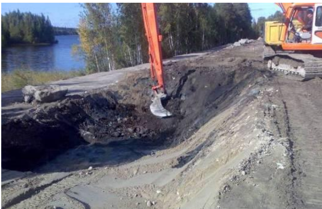
Kuvio 17: Vanhan padon purkamista ja uuden rakentamista
