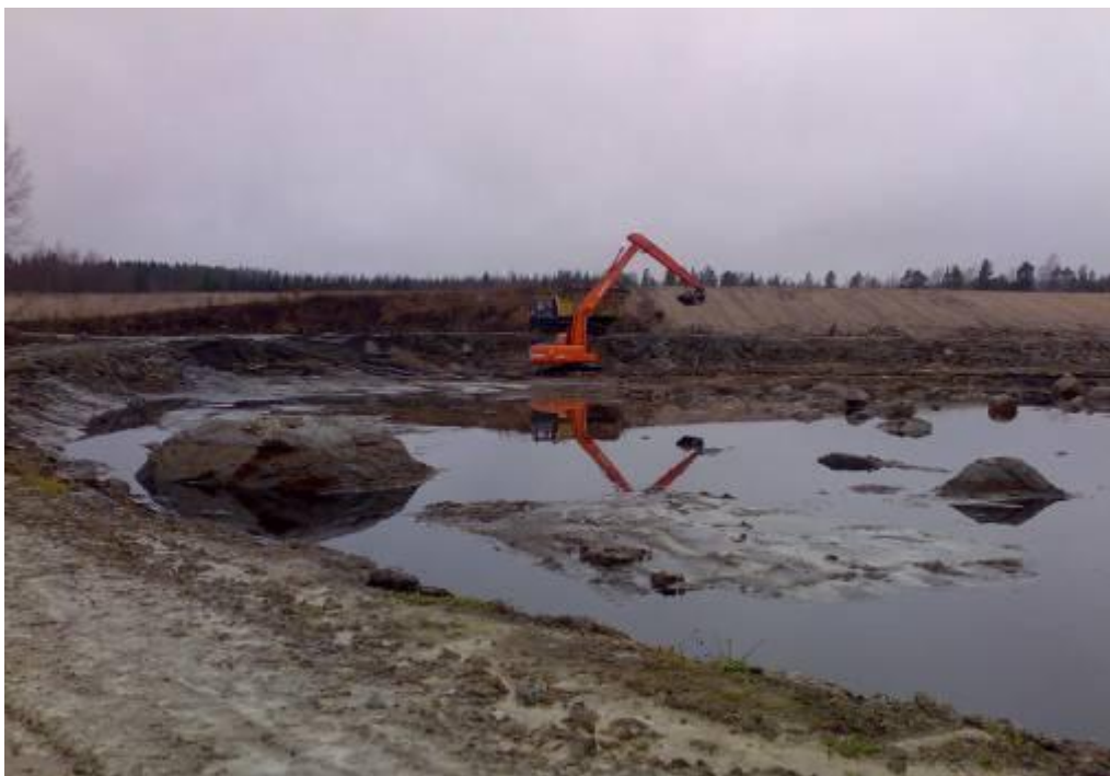
Kuvio 14: Kuitulietteen kaivua kaivinkoneella työpenkereiden muodostamasta altaasta
