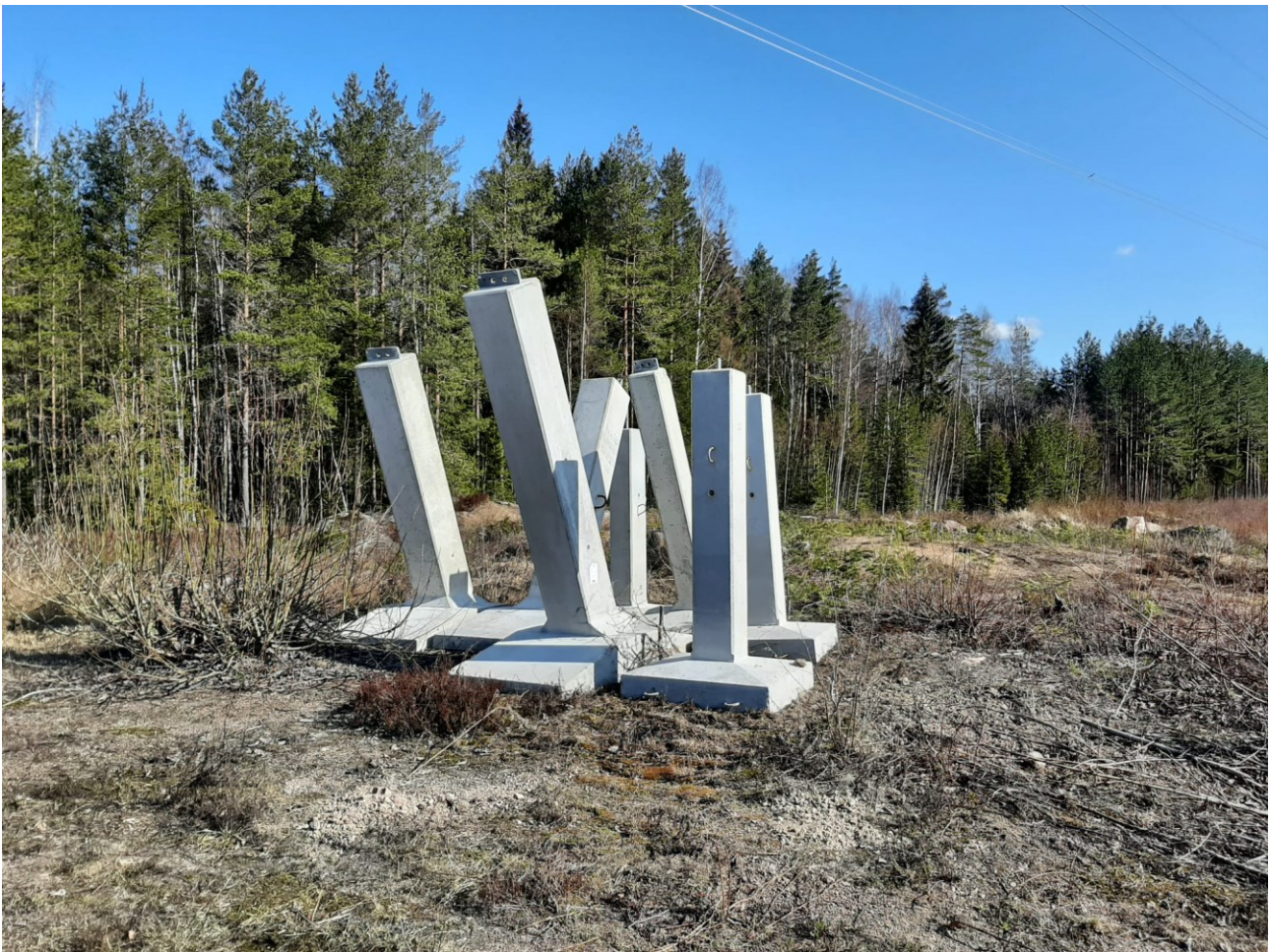
Kuvio 5 Pylväs- ja haruspilarelementtejä (Härmä 2022)
