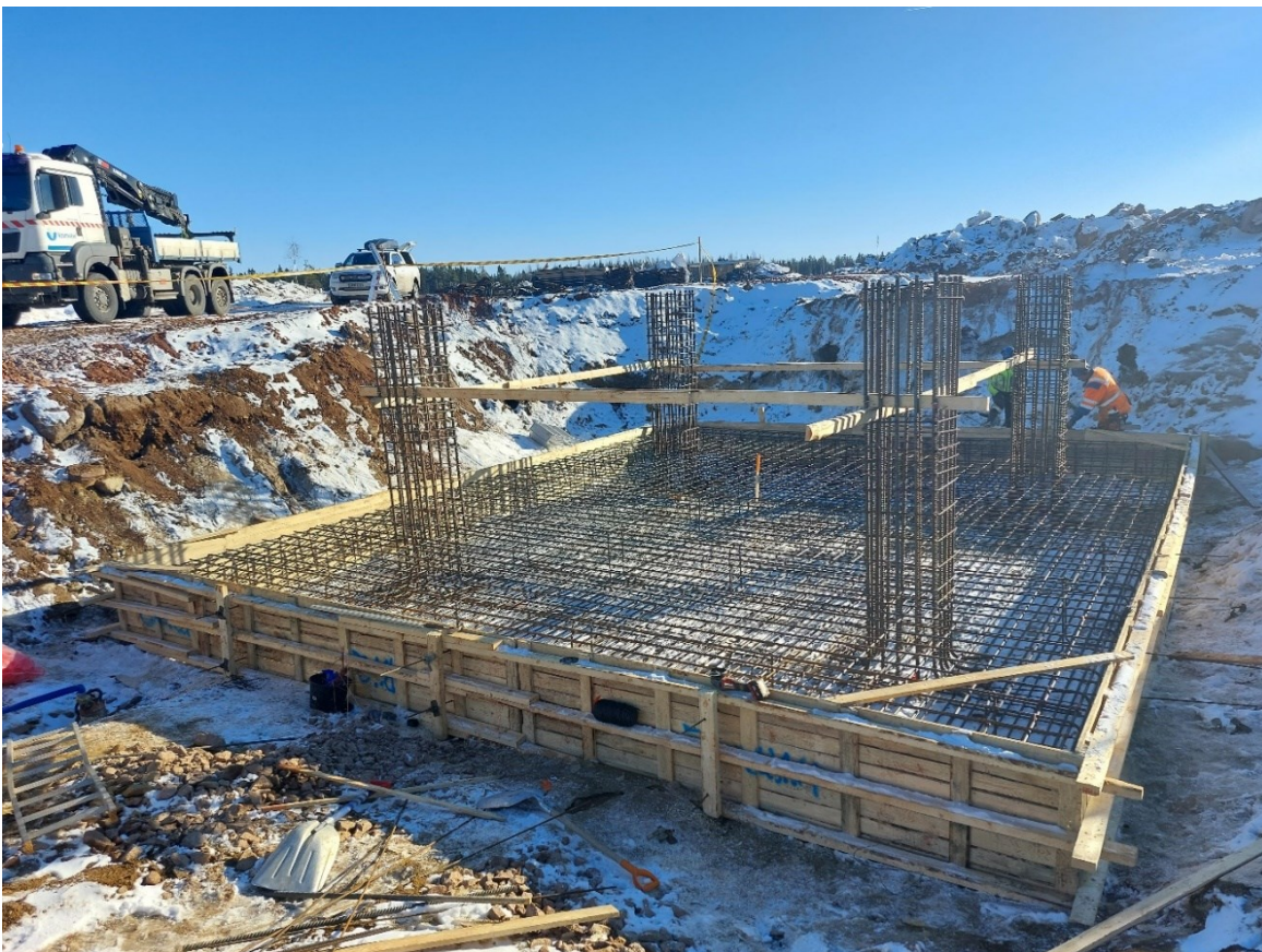
Kuvio 4 Paikallaan valettavan perustus jossa anturamuotit ja raudoitukset asennettuna (Härmä 2022)
