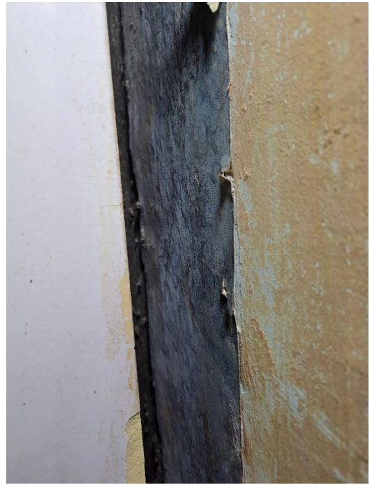
Kuva 43. Vasemmalla on valkoinen kakluuni, jonka muurista löytyi useita tapetti-kerroksia. Alin sininen jäi odottamaan irrottamista.
