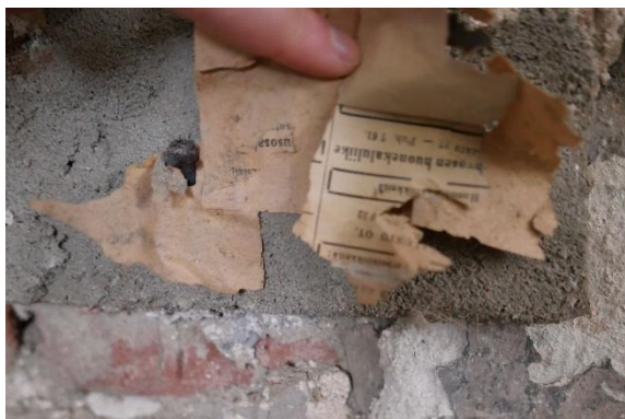
Kuva 27. Tapettikerrosten alla oli hapertunutta paperia ja sanomalehteä.
