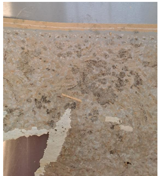
Kuva 17. Homejäljet vaalenivat puhdistuksessa.
