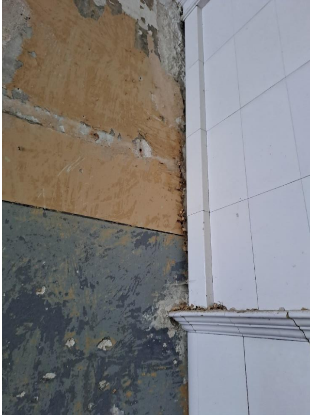
Kuva 50. Huoneen 107 kaakeliuunin muurissa oli useita tapettikerroksia.
