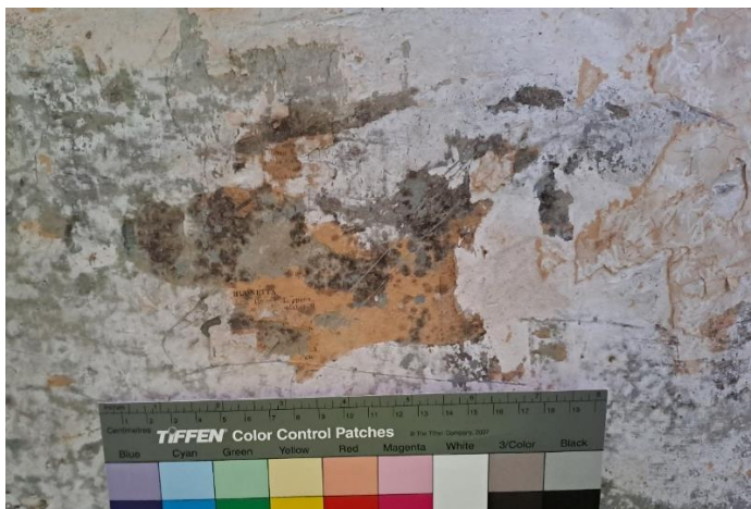
Kuva 38. Fragmenteja huoneessa 107. Sanomalehdestä on luettavissa sanat: "huonetta", "(ilman) Lappeen". Home on iskenyt tapettiliisteriin ja sanomalehteen. Oikealla näkyy jäänteitä suoraan rappauspinnassa olevasta modernimmasta tapetista.
