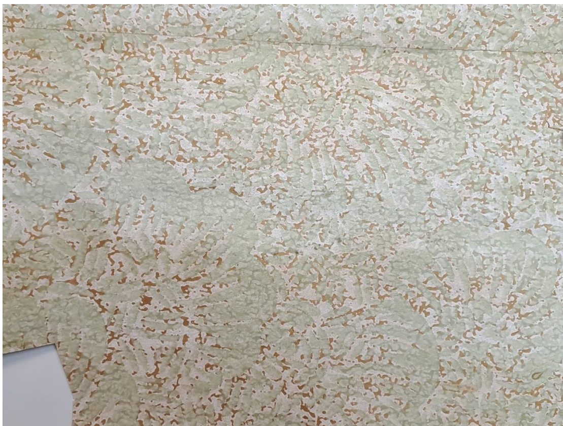
Kuva 36. Huoneen 103 kolmannessa tapettikerroksessa on kullan kimallusta.
