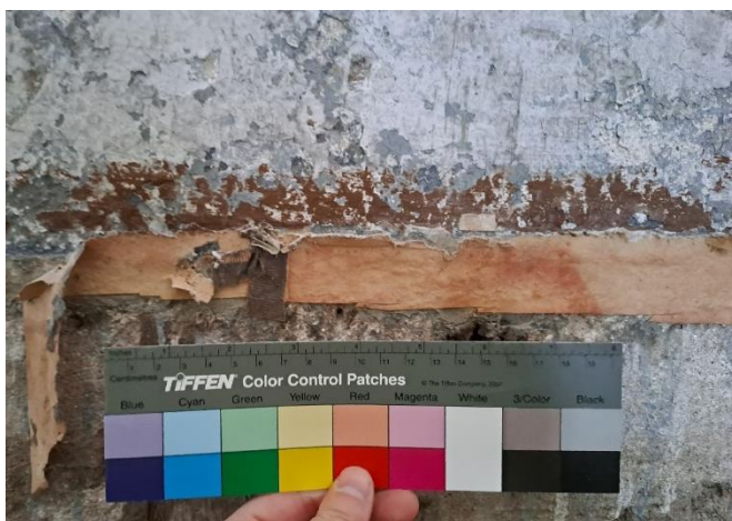
Kuva 39. Huoneen 107 ikkunaseinän tapettijäämiä. Makulatuuripaperia oli pitkinä nauhoina seinässä kiinni. Paperi tapetteineen on jäänyt mahdollisesti korotetun lattian alle piiloon.
