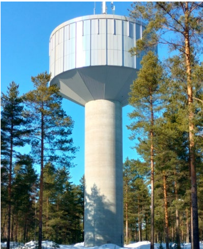
KUVA 1 Kempeleen vesitorni, jonka täyttämiseen paineenkorotuspumppua on harkittu.
