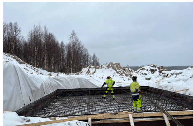
KUVA 6. Paikallaan valettavan perustuksen raudoitus työt kesken (1, s. 30)
