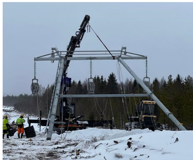
KUVA 7. Pylvään pystytys (1, s. 32)
