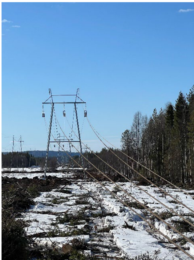
KUVA 8. Johdinveto alkamassa
