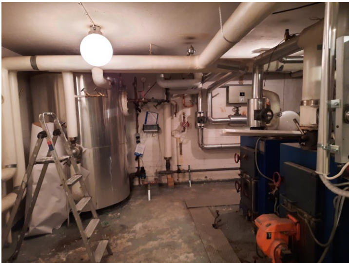
KUVA 8. Vanhaa kattilalaitosta, joka tulisi poistaa saneerauksen yhteydessä.
