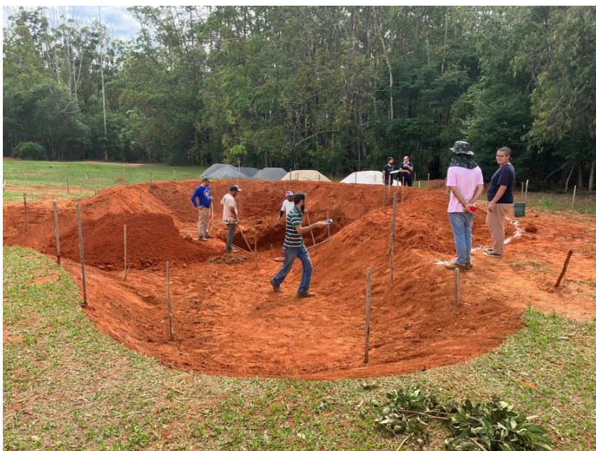
Kuva 6. Altaan pohjatyöt (Suomen suurlähetystö 2023).
