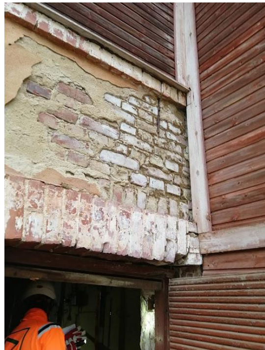
KUVA 8. Seinien kulunutta rappauspintaa, halkeilua ja haalistunutta punamultamaalia
