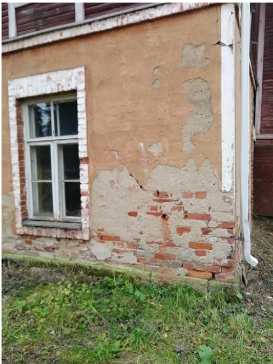
KUVA 8. Seinien kulunutta rappauspintaa, halkeilua ja haalistunutta punamultamaalia
