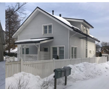
Kuva 32. Rakennuksen sisäänkäynnit sijaitsevat muulla kuin katujulkisivulla
