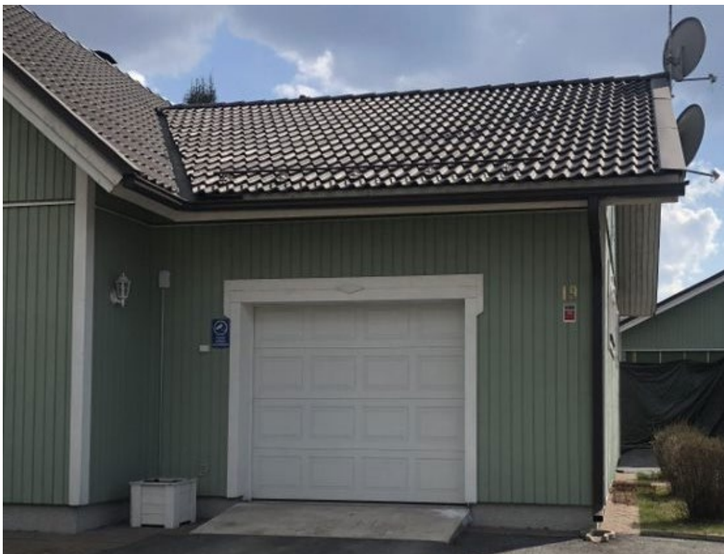
KUVA 20. Kuvassa näkyy asuinrakennuksen yhteyteen rakennettu autotalli. (Niiva 2023)
