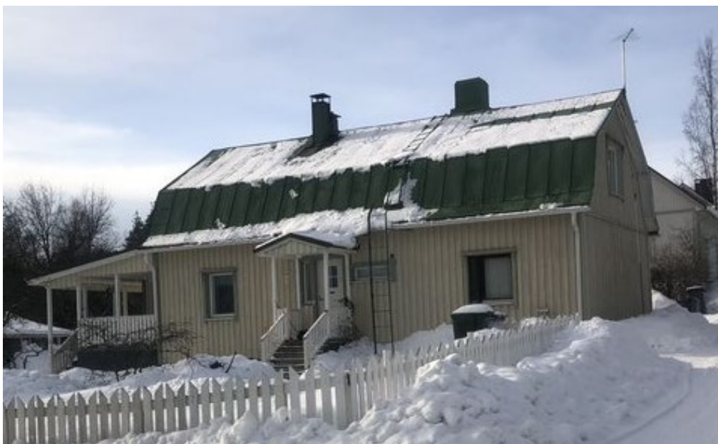
KUVA 25. Kuvassa 1920 – 1930-luvun rakennuskannalle tyypillinen mansardikattoinen pientalo. Rakennukseen on jälkikäteen tehty muun muassa terassi. Tonttia rajaa alueelle tyypillinen lauta-aita. (Niiva 2023)
