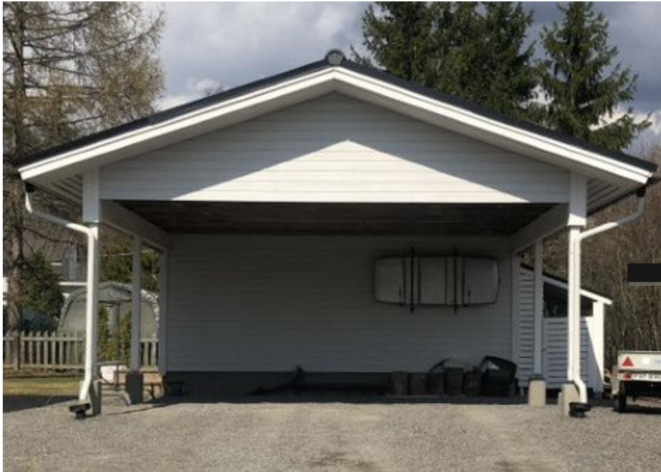
KUVA 18. Kuvassa alueella sijaitseva kahden autopaikan autokatos. (Niiva 2023)
