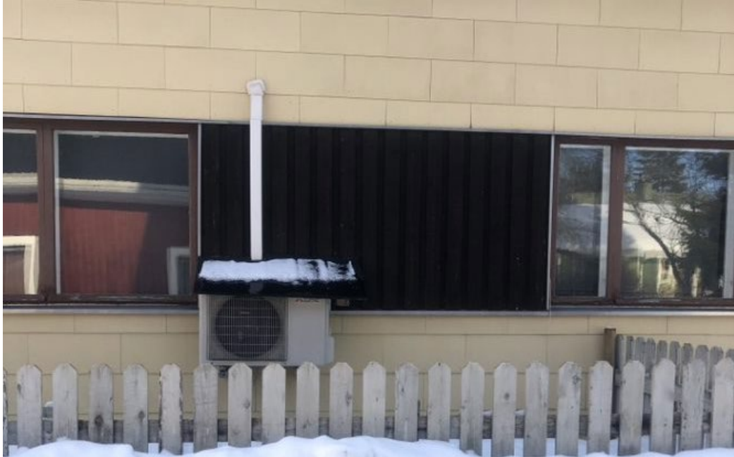
KUVA 45. Kuvassa näkyy kadun puolen julkisivussa selkeästi esillä oleva talotekniikka. (Niiva 2023)
