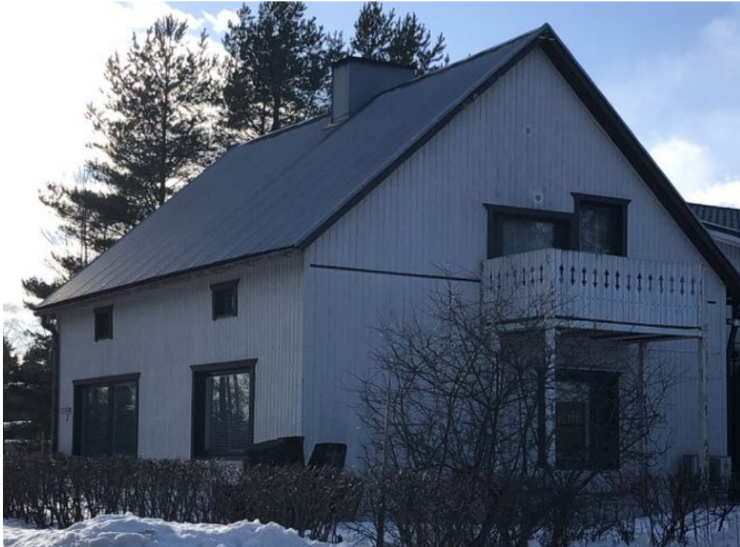
KUVA 37. Kuvassa näkyy yksi alueen parvekkeellisista rakennuksista. Parveke on kattamaton sekä parvekkeen kaide edustaa vanhaa koristeellista tyyliä. (Niiva 2023)
