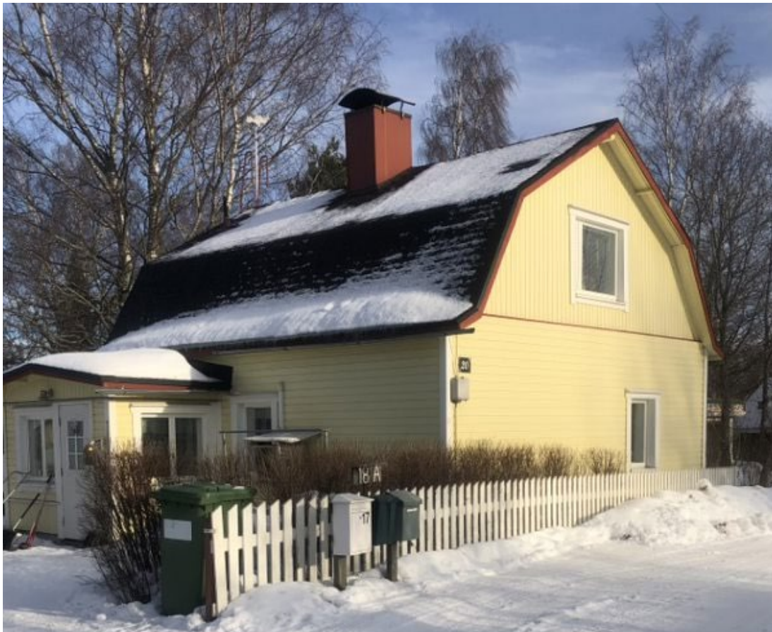
KUVA 17. Kuvassa mansardikattoinen päärakennus, jossa kuisti on sijoitettu rakennusmassaan ulokemaisesti. (Niiva 2023)
