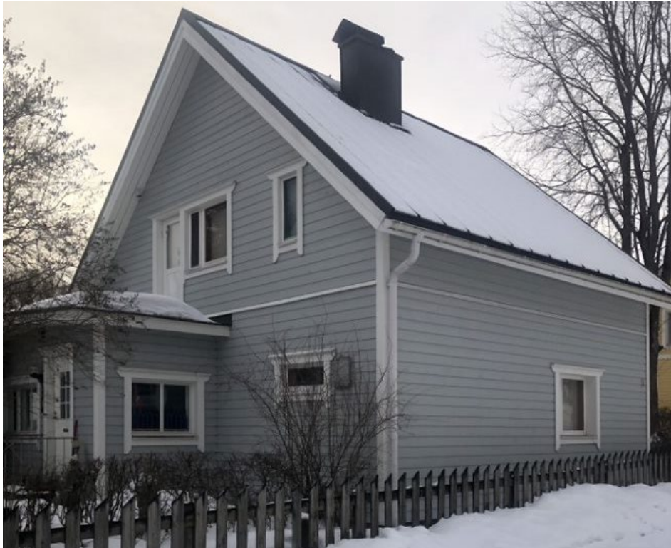
KUVA 41. Kuvassa onnistuneesti korjattu rakennus, jossa mineriittiverhous on vaihdettu laudoitukseen. Vaikka rakennuksen kuistin päällä oleva parveke on poistettu käytöstä, parvekkeen ovi on jätetty julkisivuilmeen säilyttämiseksi. (Niiva 2023)
