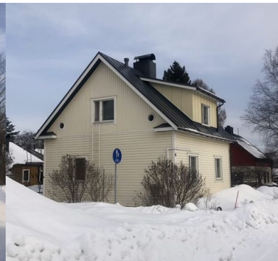
Kuva. 13. 1,5-kerroksinen 1:1 kattokulman asuinrakennus
