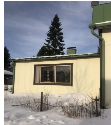
Kuva 22. Laajennussiipi räystäslinjan alapuolella.
