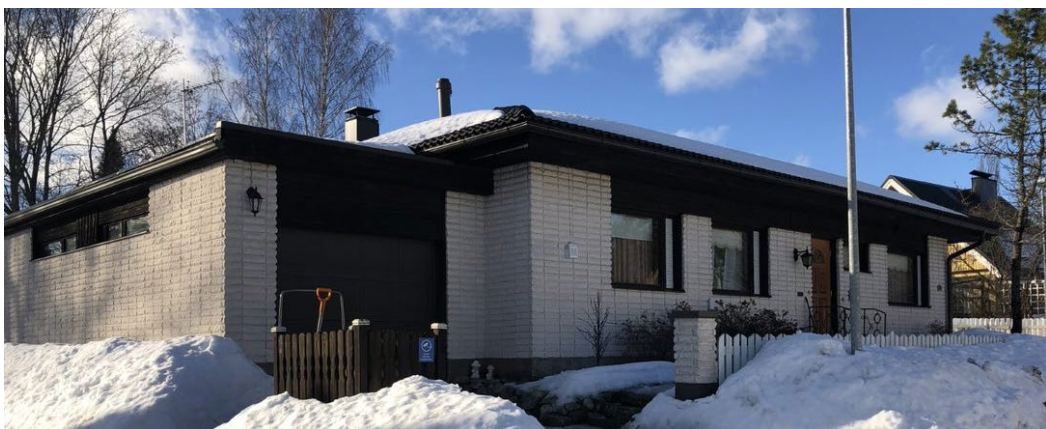
KUVA 30. Tyypillinen 1960-1980-luvun aumakattoinen tiilirakennus Topinkadulta, jossa autosuoja ja asuinrakennus ovat kytkettyjä samaan rakennusmassaan. (Niiva 2023)
