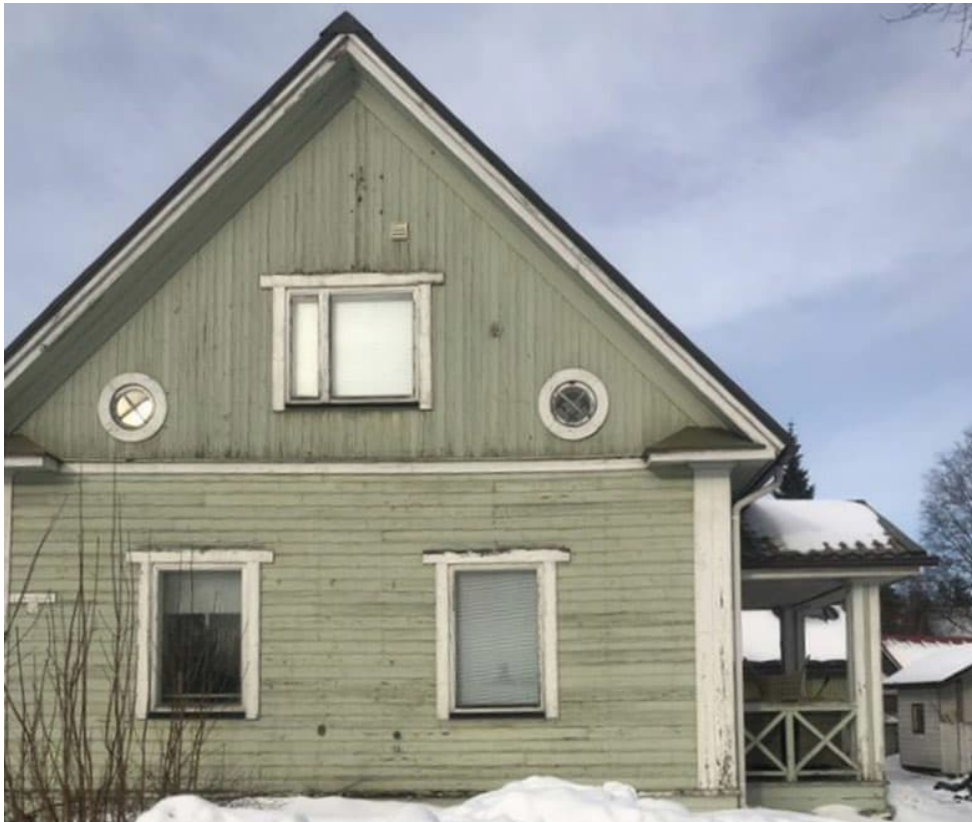
KUVA 36. Rakennuksen sisäänkäynti on pihan puolella. (Niiva 2023)
