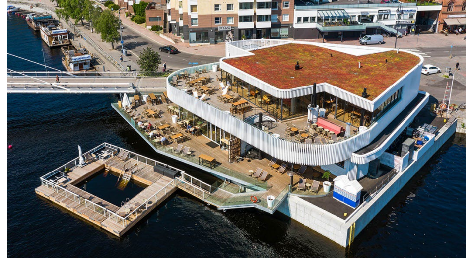
Kuva 5 Saunaravintola Kuuma:n maksaruohokatto. Kuva: Katepal.fi
