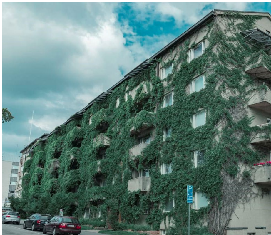
Kuva 21 Villiviinin vuoraama julkisivu Jyväskylässä. Rakennuksen viherjulkisivu on vaikuttava osa asuinalueen identiteettiä ja se viilentää sisätilojen lämpötilaa kesäisin haihduttavuudellaan. 130 Kuva: Simo Pitkänen
