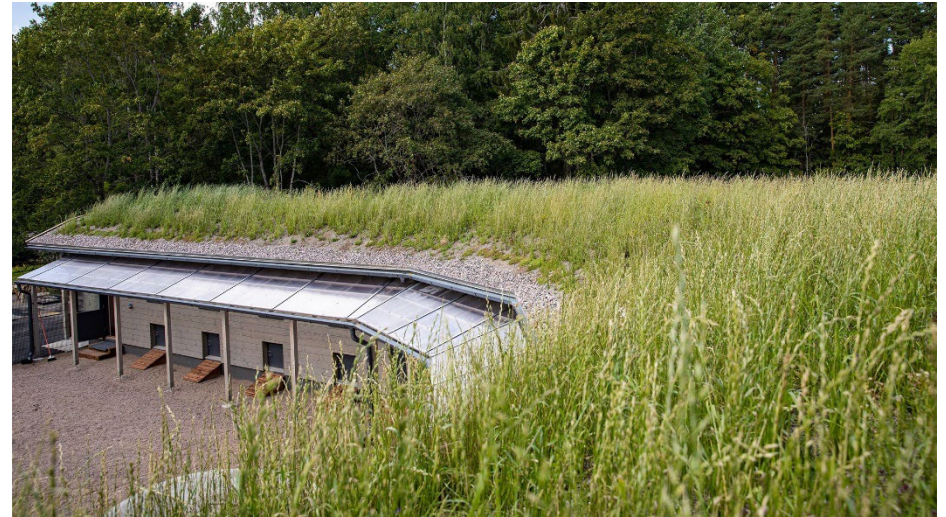
Kuva 9 Heinolan lintutarhan vehreä heinäkatto toteutettiin esteettisten vaikutusten aikaansaamiseksi. Kuva: Omatloyhtiö.fi
