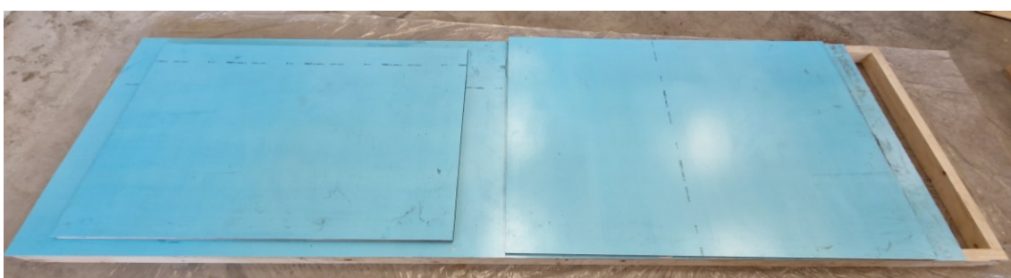
Kuva 23. Vaahto-PVC-levyt liimattuna katon, etulevyn ja oven varien päälle
