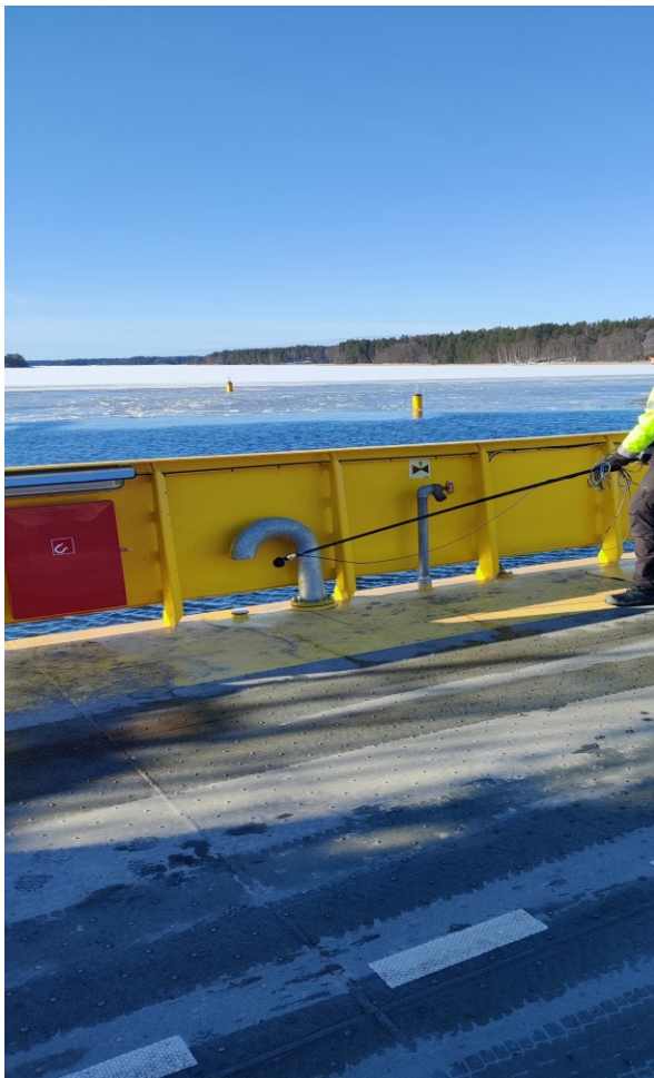
Kuva 6. Vetotilan ilmanvaihtokanava eli ”raakitorvi”.
