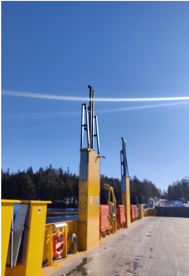
Kuva 8. Lossin pakoputki eli " korsteeni".
