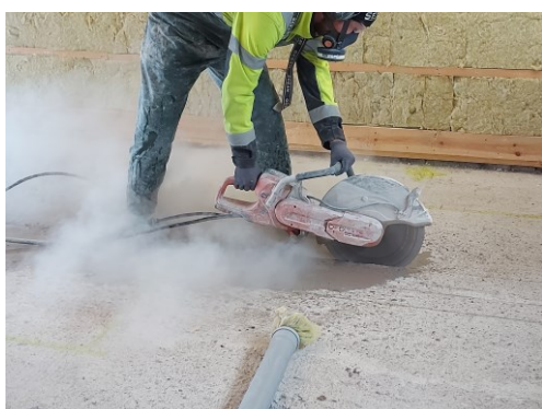
Figur 2. Sågning av gammalt betonggolvet utan dammreducering.
