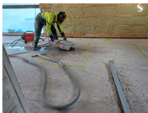
Figur 3. Sågning av betonggolvet med våtsågning.
