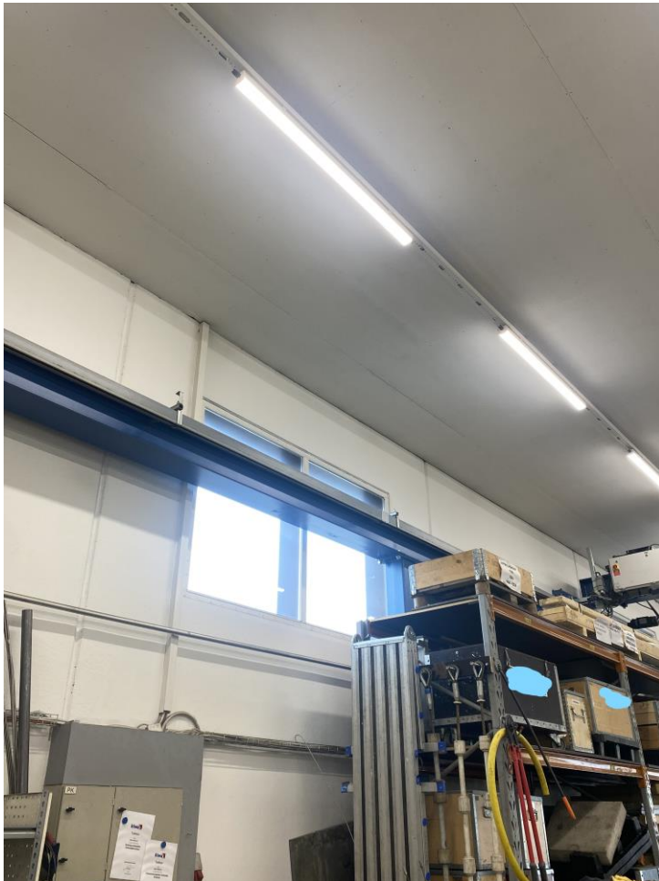
KUVA 14. Työtilan yläosassa sijaitsevia ikkunoita (Syrjä 2023).
