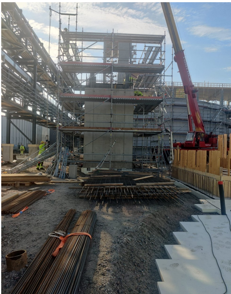
Kuva 7. Hissikuilun ensimmäinen kerros valettu. (Paasivuori 2022.)
