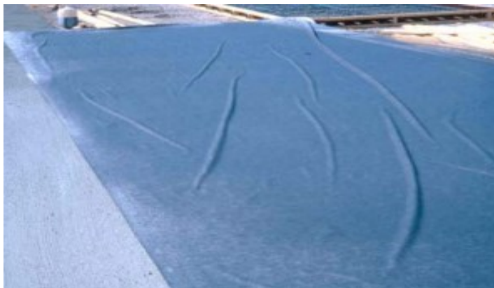
Kuva 10. Muovi eristää kosteutta haihtumasta betonista liian nopeasti. (BLY 3 julkaisuajankohta tuntematon.)
