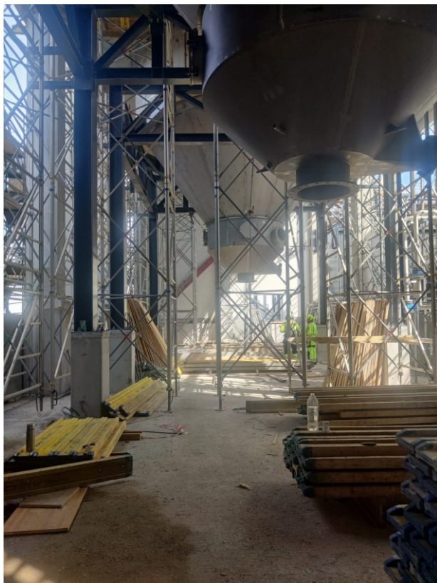
Kuva 1. Holvin alla olevat muottitornit varaavat alapuolisen tilan useaksi viikoksi. (Paasivuori 2022.)
