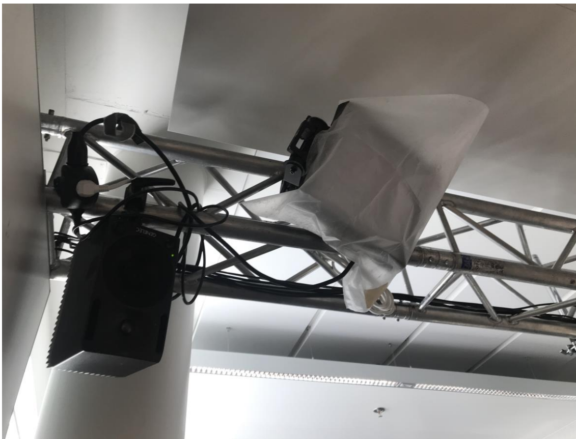
Kuva 3. Kattoon ja seiniin kiinnitetty teräksinen tukipalkki, kaiuttimien ja taustavalojen kiinnittämistä varten. Kaiuttimet kiinnitettiin molemmille puolille huonetta teräspalkkiin, jotta ääni saataisiin tasaisesti jakautumaan tilaan. Ulkopuoliselta meteliltä vältyttiin rakentamalla studio äänieristettyyn huoneeseen.
