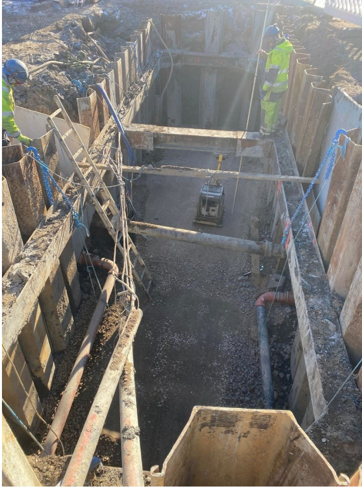
Kuva 1. Valmis ponttikaivanto alitustyötä varten
