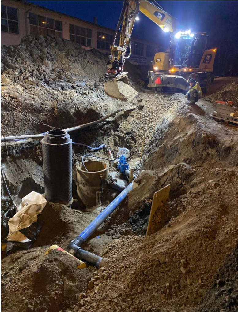
Kuva 2. Liitos vanhaan vesijohtoon urakkarajalla
