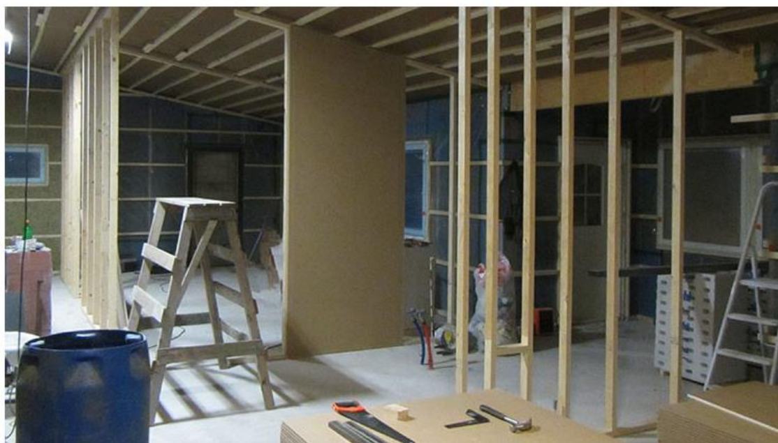
KUVA 1. Yleinen näky työmaalla puurungosta. (Rakentaja 2023)
