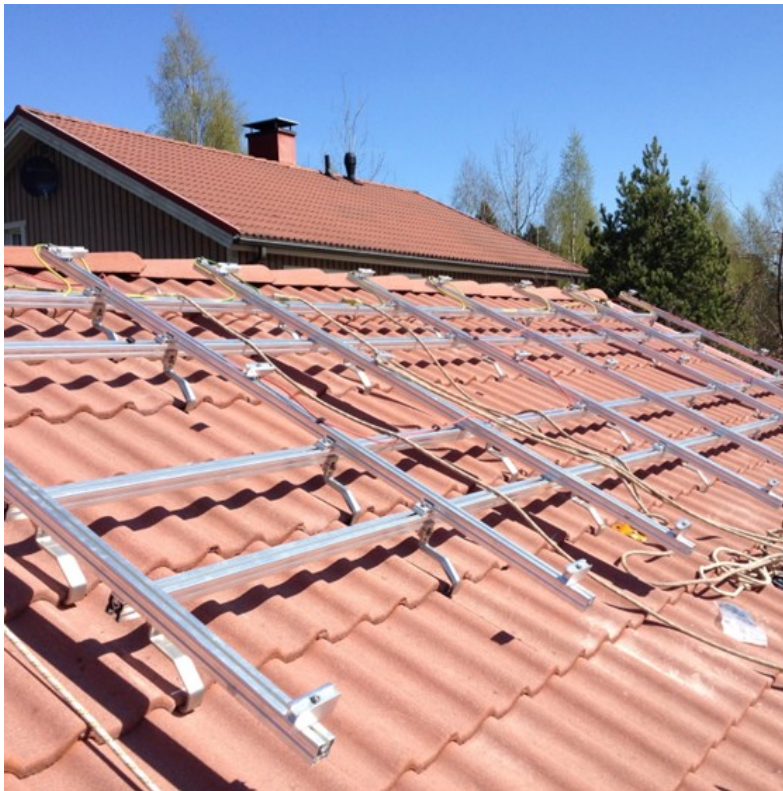
Kuva 8. Tiilikattoasennus asennuskannakkein ja käyttäen alumiinikiskoja
