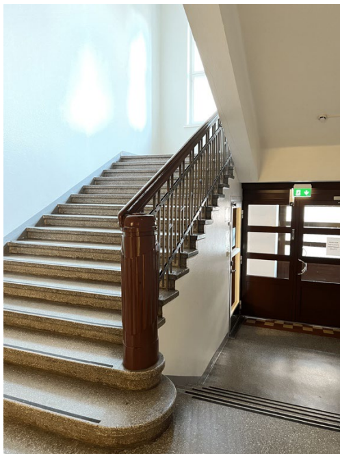
KUVA 6. Pääporras ja Maaherrankadun sisäänkäynti (Kortelainen 2023)
