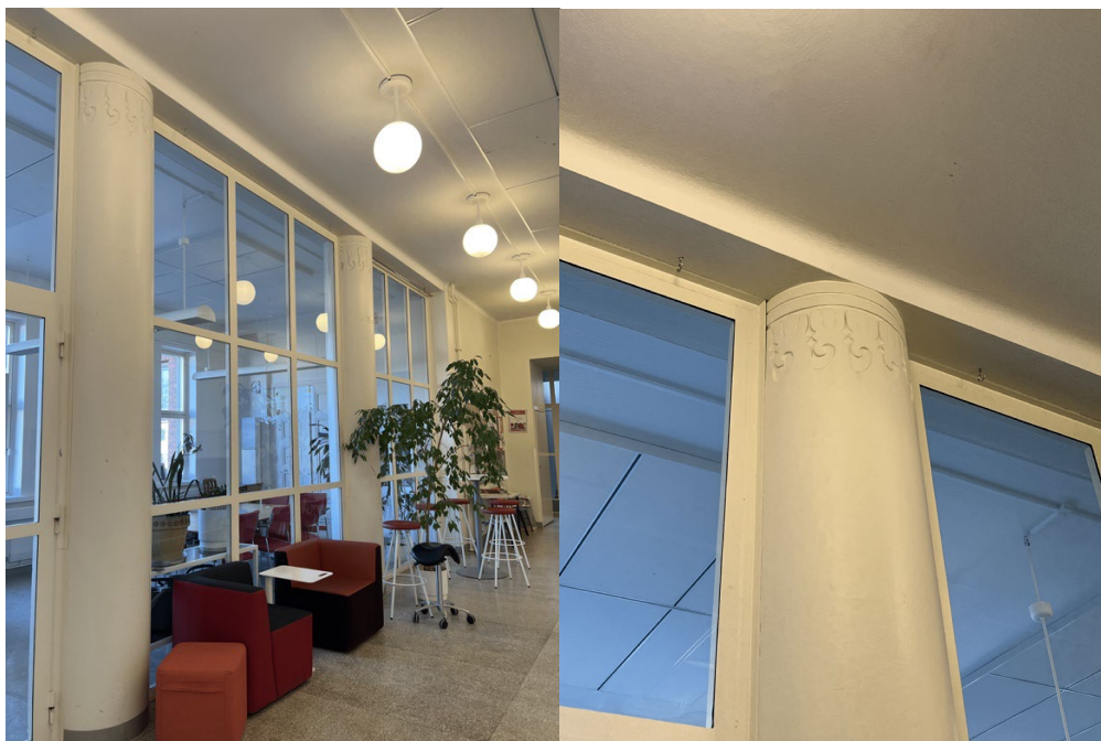
KUVA 8. Toisen kerroksen käytävä ja pilarin ornamentit (Kortelainen 2023)
