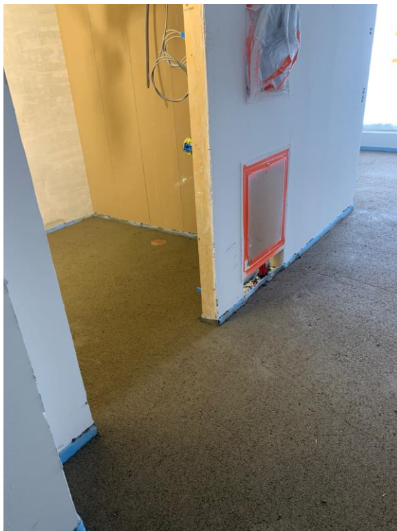
(KUVA 6. Valmiita lattiapintoja valun jälkeen. Lakanen 2023)
