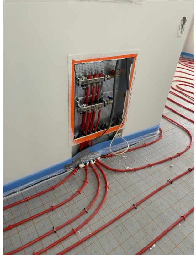
(KUVA 10. Jakotukin asennus ja putkitus, Lakanen 2023)
