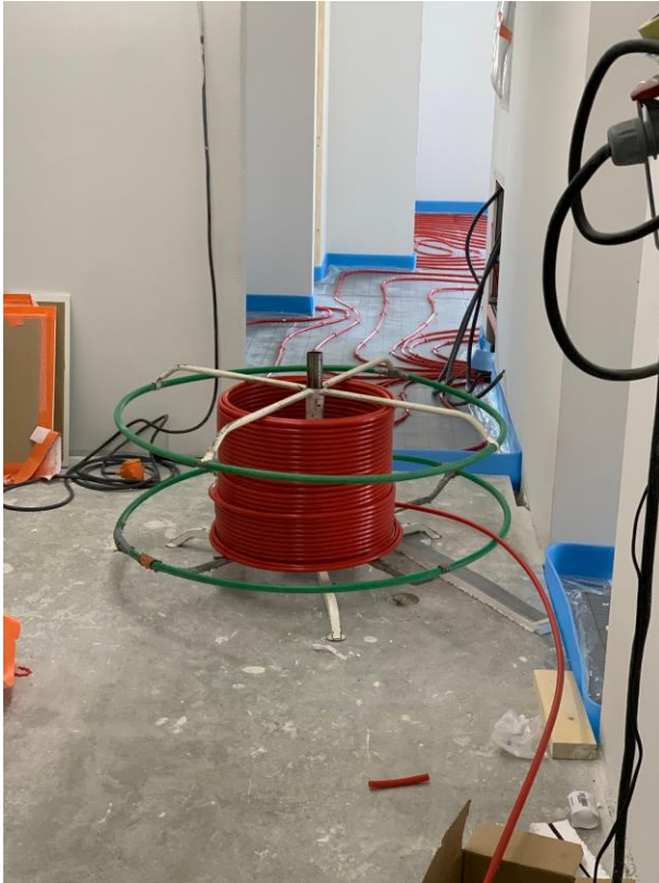
(KUVA 9. Putkitustyö rullalta, Lakanen 2023)
