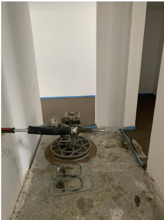
(KUVA 4. Pinta tiivistetään ja hierretään koneella. Lakanen 2023)
