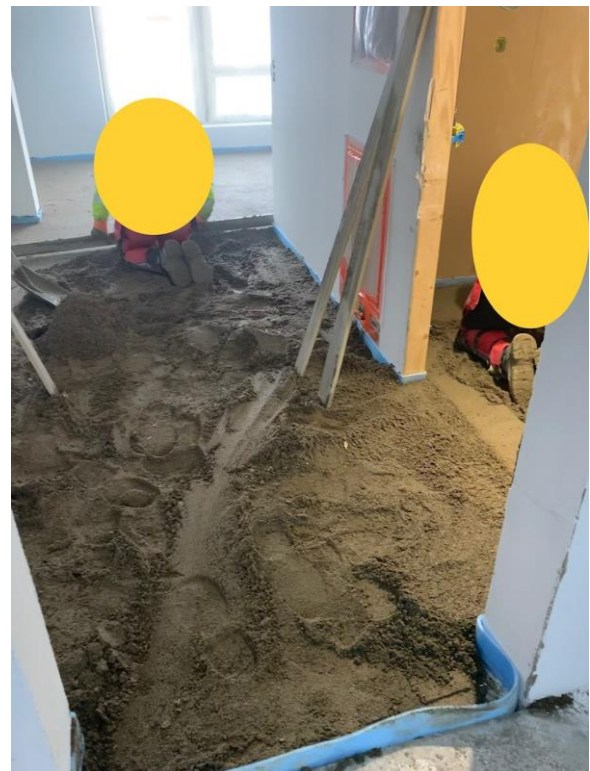
(KUVA 5. Maakostean betonin levitys ja kaatojen muotoilu. Lakanen 2023)
