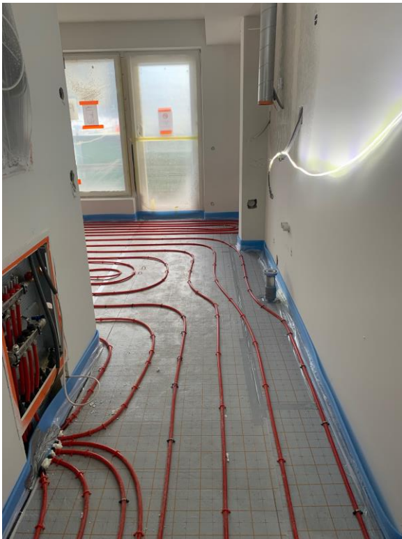
(KUVA 11. Yleiskuva asennetusta lämpölattiasta, Lakanen 2023)
