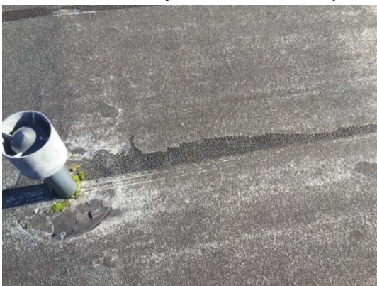
Kuva 7 a ja b. Matalan osan läpivientejä
