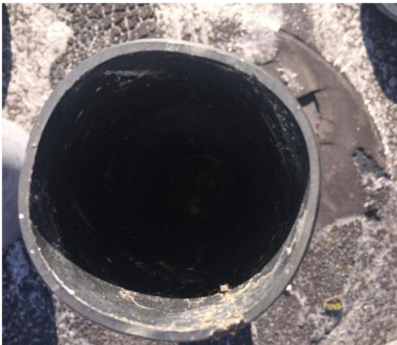
Kuva 9. Esimerkkikuva läpiviennistä.
