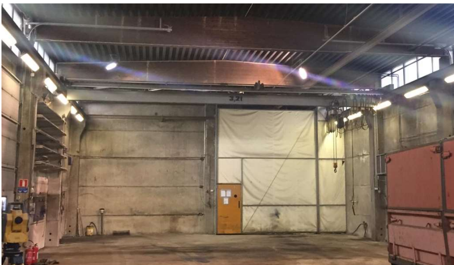
Kuva 15. Hallin sisäkuva jossa näkyy nosturi
