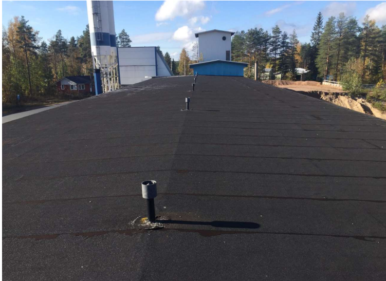
Kuva 10. Tuotantohallin bitumikermikatto
