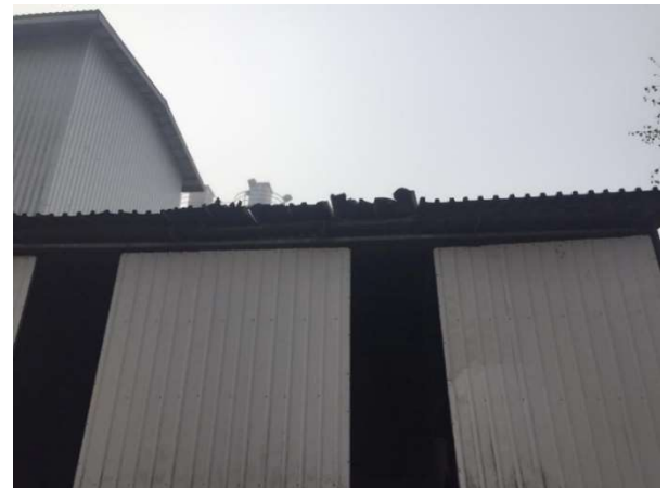
Kuva 4. Korkean osan katon räystääs pohjoispuolella
