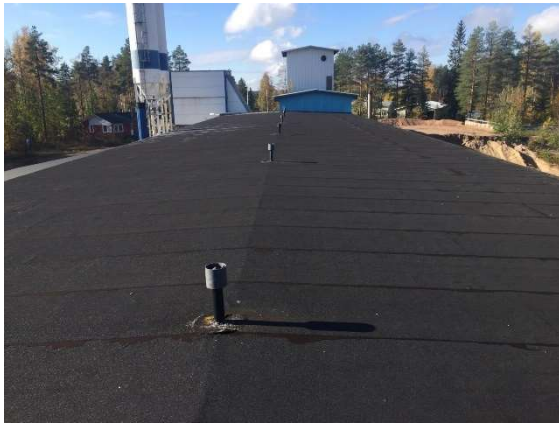
Kuva 5. Matalan osan katto
