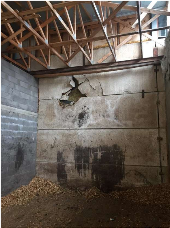
Kuva 11. Lämmönjakohuoneen viereinen katos
