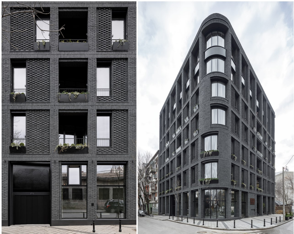
Kuva 23. Mustan julkisivun voimakas vaikutelma. Kentät erottuvat julkisivusta vaihtelevan muuraustavan ansiosta erittäin selvästi. Kuvat: Relja Ivanic, Archdaily
