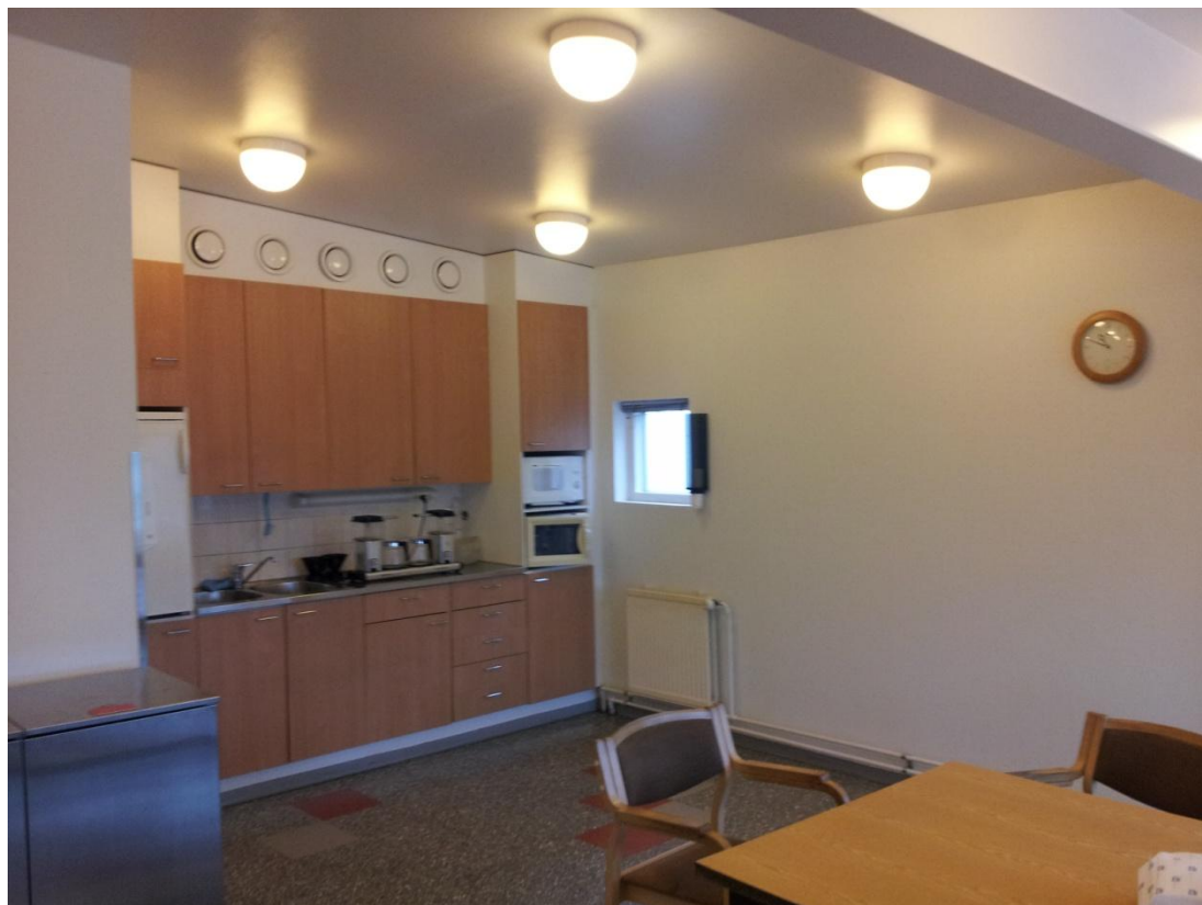
Kuva 8. Taukuhuoneen poistoilmapäätelaitteet.
