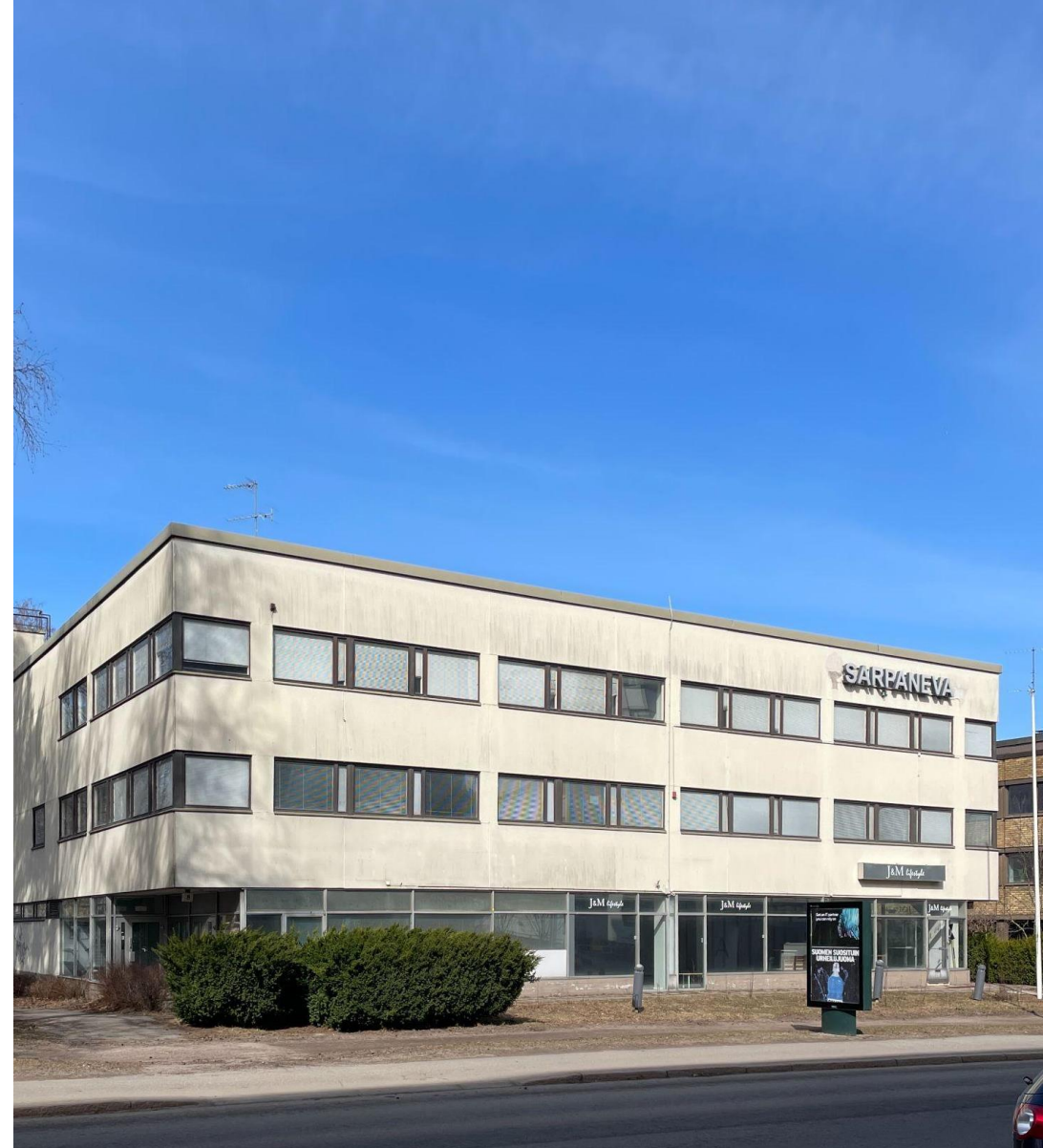
Kuva 7. Kuvassa rakennuksen kaakon puoleinen julkisivu (pääjulkisivu).
