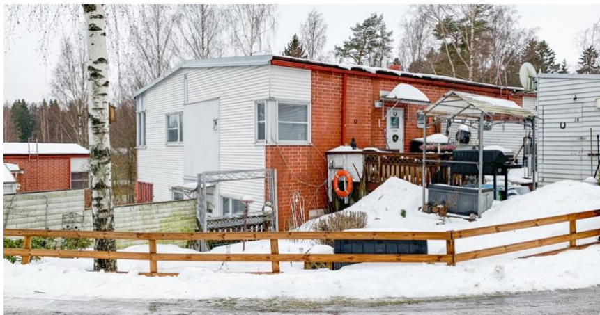
Kuva 34. Vaikka säilyvissä rakennuksissa ei ollut parvekkeita, on asukkaiden halussa olleet piha-alueet muodostaneet ajansaatossa moni-ilmeisiä lauta-aidoin rajattuja alueita. Rakennusten toisen kerroksen sisäänkäynnit on erotettu toisistaan myös vaakalaudoitetuin puuaidoin. Kuva Kim Mäenpää.
