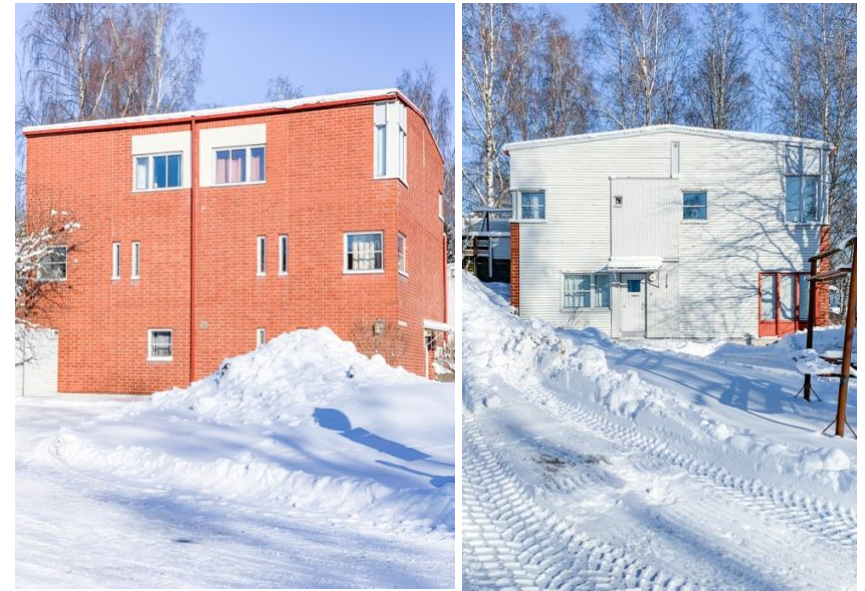
Kuva 30. Säilyvien rakennusten julkisivuissa on käytetty hyväksi horisontaalien ja vertikaalien aiheiden dynamiikkaa. Ikkunat, kokonsa ja puitejakonsa puolesta, sekä sisäänkäynnin paneelikenttä luovat voimakasta vertikaalisuutta. Tätä tasapainottaa rakennusten päätyjen vaakalautaverhous, sekä vertikaali-ikkunoiden muodostamat vaakasarjat, sekä neutraalimmat neliöikkunoiden vakaapuitejaot. Kuvat Kim Mäenpää.
