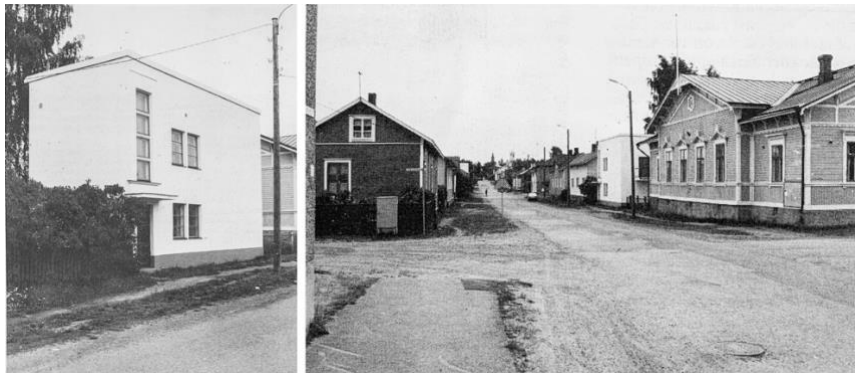
Kuva 12. Vasemmalla Porin Reposaaren vanhalle puutaloalueelle suunniteltu funktionaalinen Puhelinyhdistyksen kivitilo. Oikealla rakennus katukuvassa. Rakennuksen ainoa yhteys ympäristöönsä on sen koko (pituus, leveys ja korkeus) muuten muodostaen suuren kontrastinympäristönsä kanssa. Tästä huolimatta Badermann antaa rakennukselle täydet kymmenen pistettä sen sopeutumisesta. 13 Kuvat Elmar Badermann 1990.
