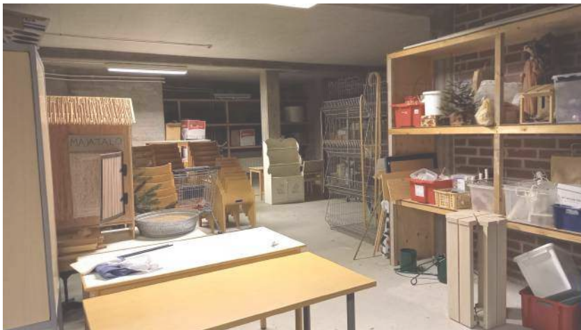
Kuva 26. Näkymä kellarikerroksen varatilasta. Varatilaan on valettu rakentamisen jälkeen raakabetonilattia.
