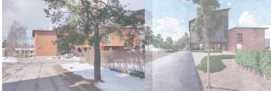
Kuva 38. Kerokujan pääty muuttuu avoimemmaksi ja ilmavammaksi uuden massan korottamisen ja maantasokerroksen läpinäkyvyyden myötä.
