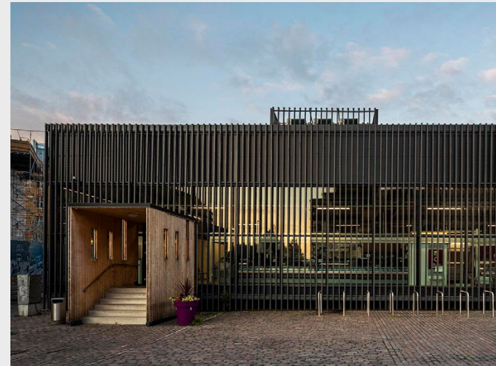
Kuva 42. Hakaniemen kauppahallin väistötila. Kuva: Insinööritoimisto Mäkelä Oy
